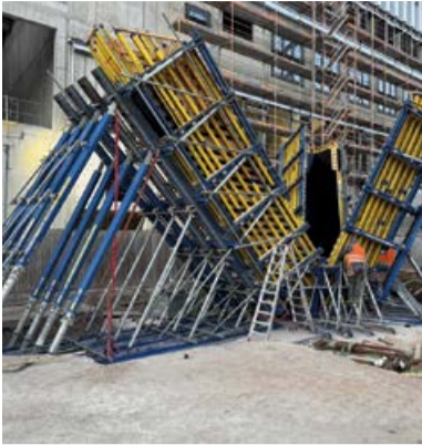
Vor der Betonage der Sichtbetonstützen war eine anspruchsvolle 3D-Konstruktion der Sichtbetonschalung notwendig.
