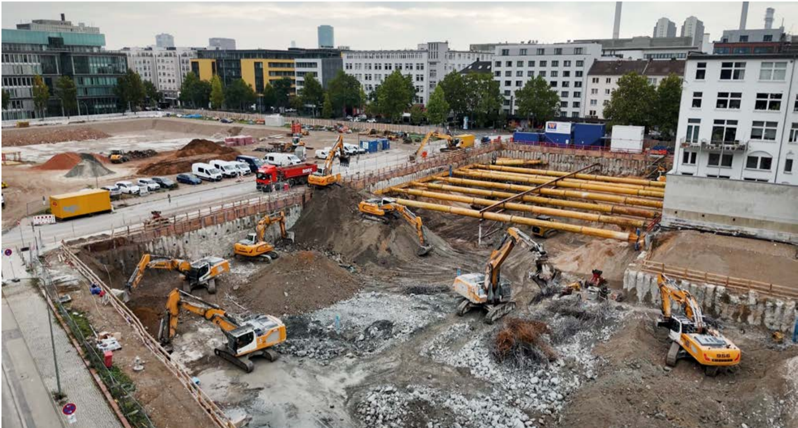
Szenen wie auf einer Baumesse: Bis zu zehn Bagger und fünf Großbohrgeräte arbeiteten parallel an der Herstellung der riesigen Baugrube für den ersten und größten Bauabschnitt des Projekts Hellerhöfe im Frankfurter Gallusviertel. Foto aus Video Bauwens
