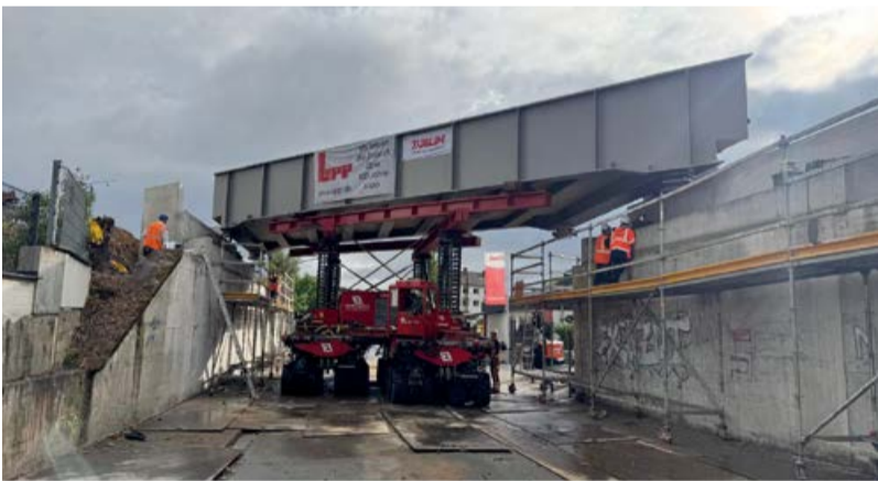
Der Einhub der Stahlbrücke erfolgte mit SPMT.
