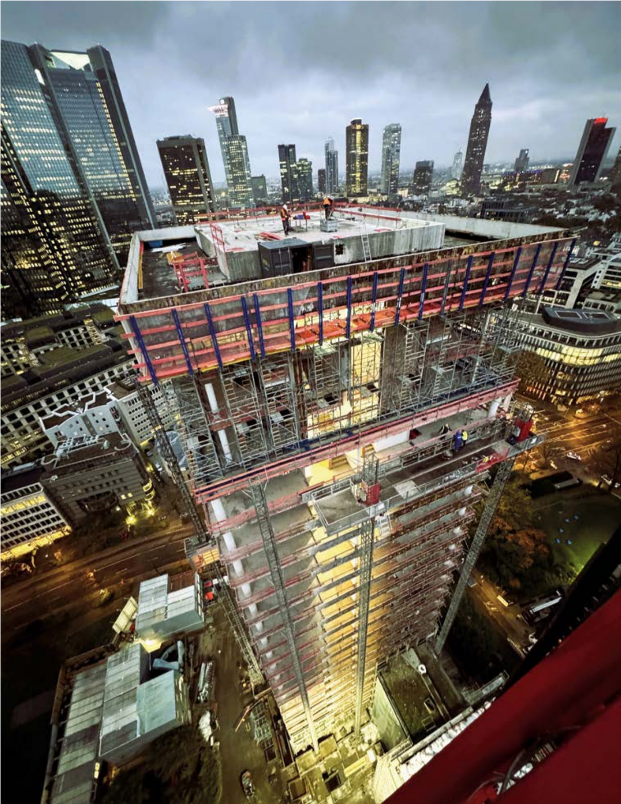
Beim Grobabbbruch in den oberen Etagen muss das Baustellen-Team äußerst feinfühlig vorgehen: Anhand detaillierter Abbruchkonzepte werden die obersten Geschossdecken zwischen dem 19. und 23. Obergeschoss zunächst vollständig abgetragen, um sie später mit der erforderlichen Tragfähigkeit neu zu errichten.
