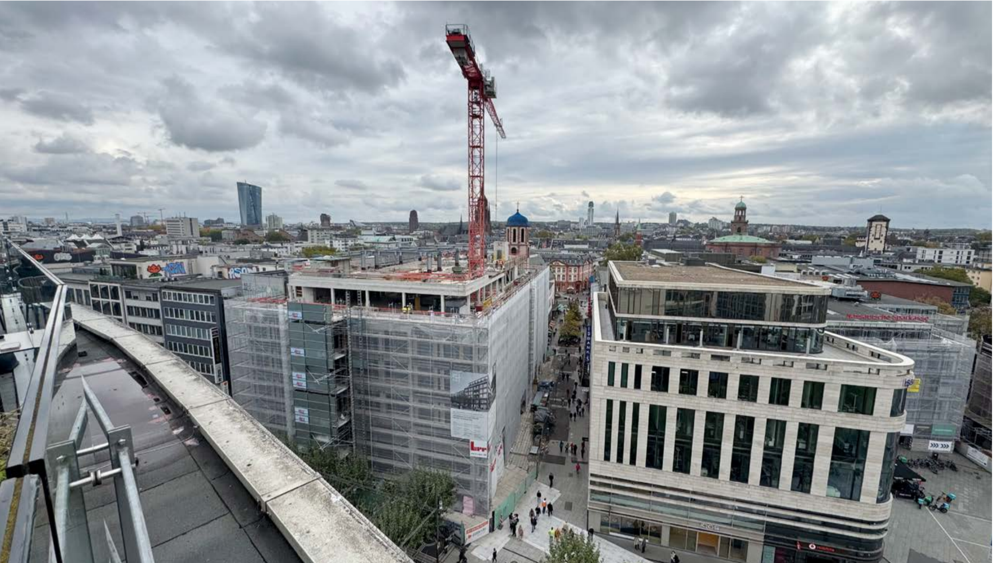
Abgesehen von kleineren Restleistungen sind die Arbeiten am Rohbau inzwischen weitgehend abgeschlossen. Erstmals in Frankfurt wurde CO 2 -armer Level-4-Beton verbaut, ebenso kam CO 2 -reduzierter Profil- und Bewehrungsstahl zum Einsatz.
