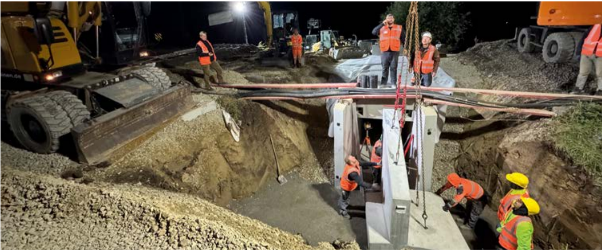
Der Durchlass unter der Bahnstrecke wurde erneuert.
