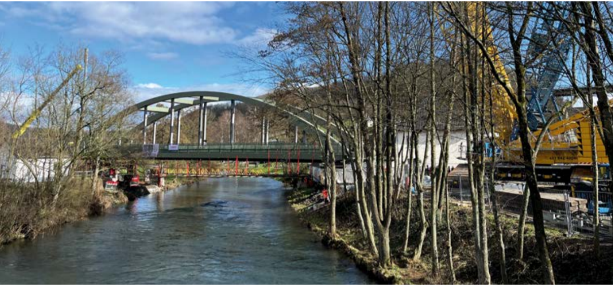
Eine neue Stabbogenbrücke führt über die Agger.
