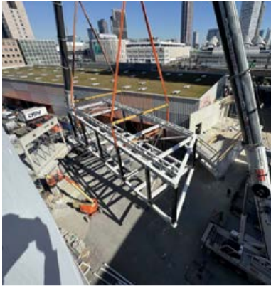
Die 22 Meter lange kleinere Brücke wurde zunächst am Boden vormontiert und dann mit zwei Mobilkranen eingehoben.
