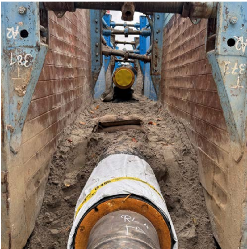
Bevor die rund 150 Meter lange Fernwärmeleitung DN 300 verlegt werden konnte, mussten besondere Vorkehrungen getroffen werden, um einen kontaminationsfreien Arbeitsbereich zu schaffen.
