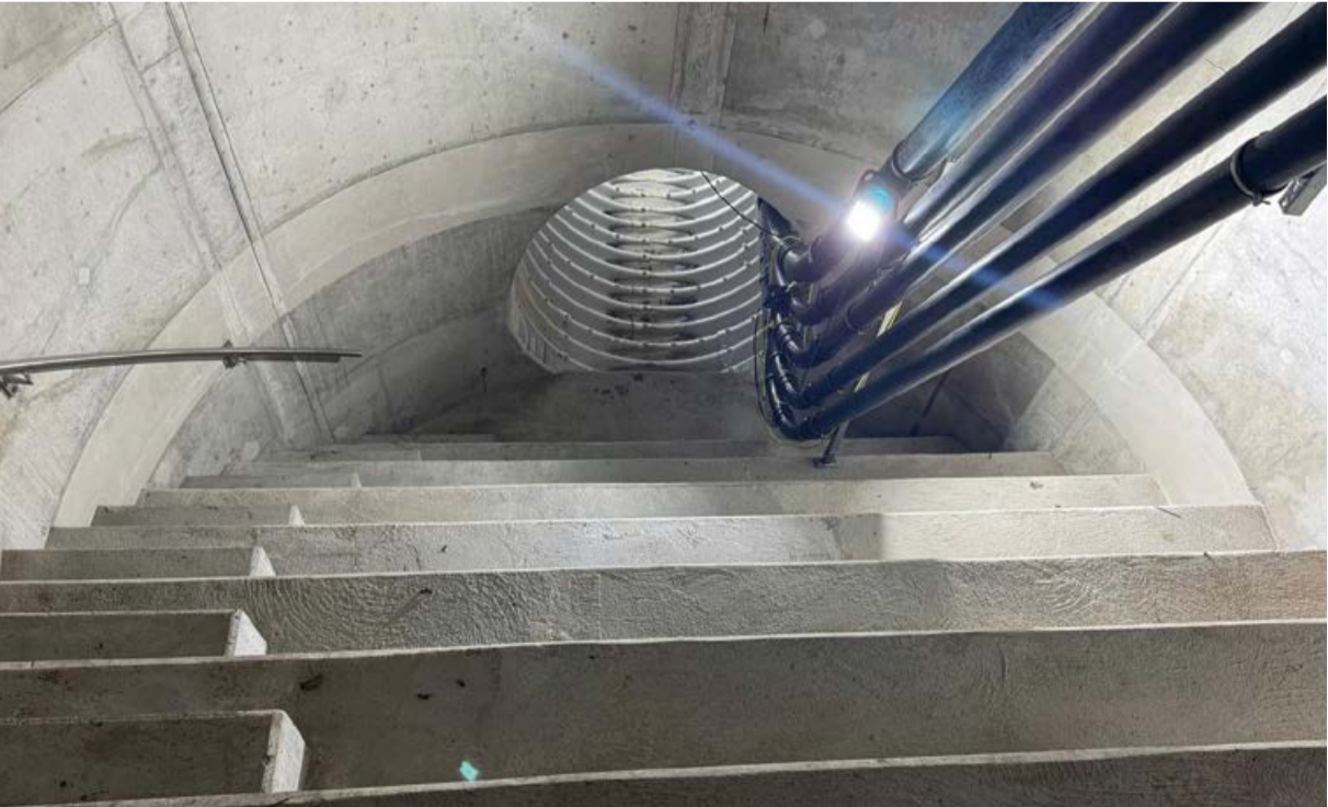
Die Treppenanlage des runden Schachtbauwerks wurde abschnittsweise errichtet. Von hier aus ist das bereits fertiggestellte Teilbauwerk 01 zu sehen, über das im letzten Lupp Report ausführlich berichtet wurde.
