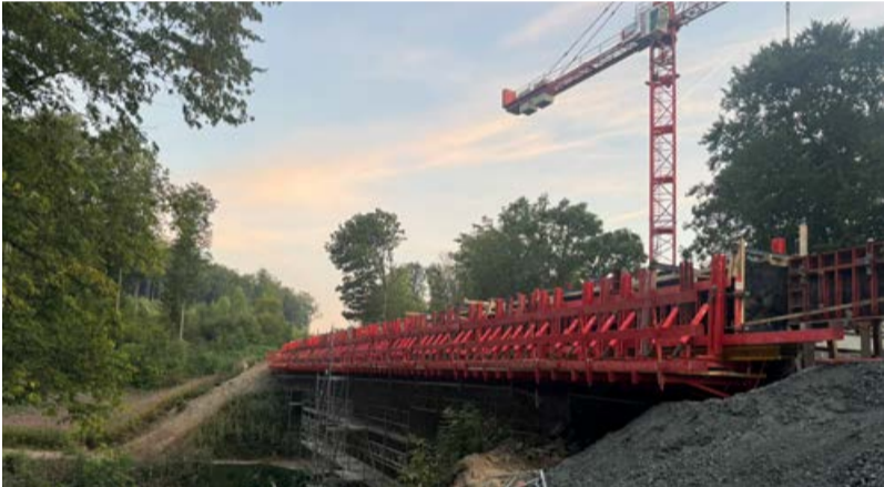
Die erneuerte dreifeldrige EÜ führt über den Hirzbach.
