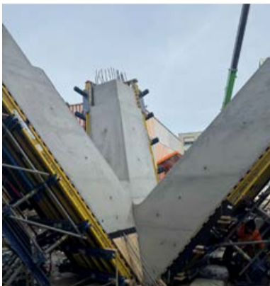
Die erfolgreich betonierten Sichtbetonstützen können ausgeschalt werden.
