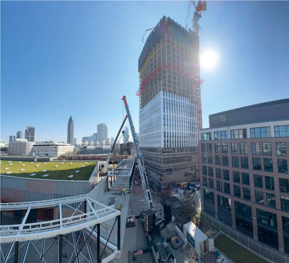
Für den Hub der größeren Stahlbaubrücke mit 43 Meter Länge und 100 Tonnen Gewicht kamen zwei 450-Tonnen-Mobilkrane zum Einsatz.
