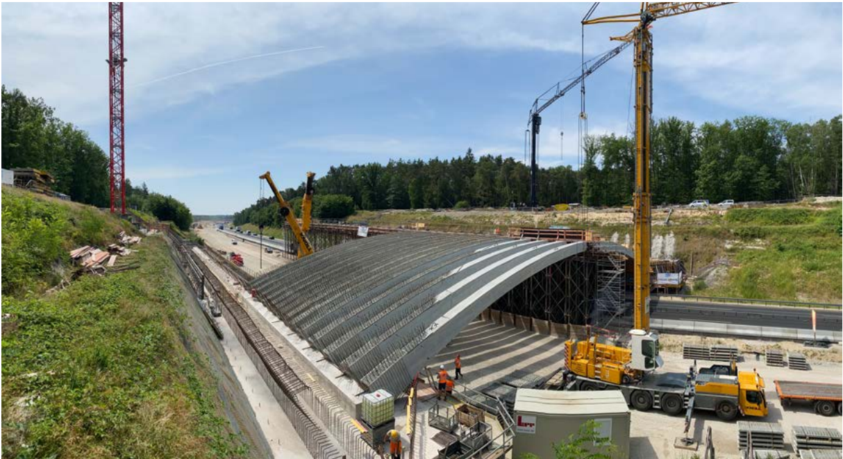
Die Grünbrücke überquert die sechsspurige Autobahn A3, sodass wildlebende Tiere gefahrlos von der einen auf die andere Seite gelangen.
