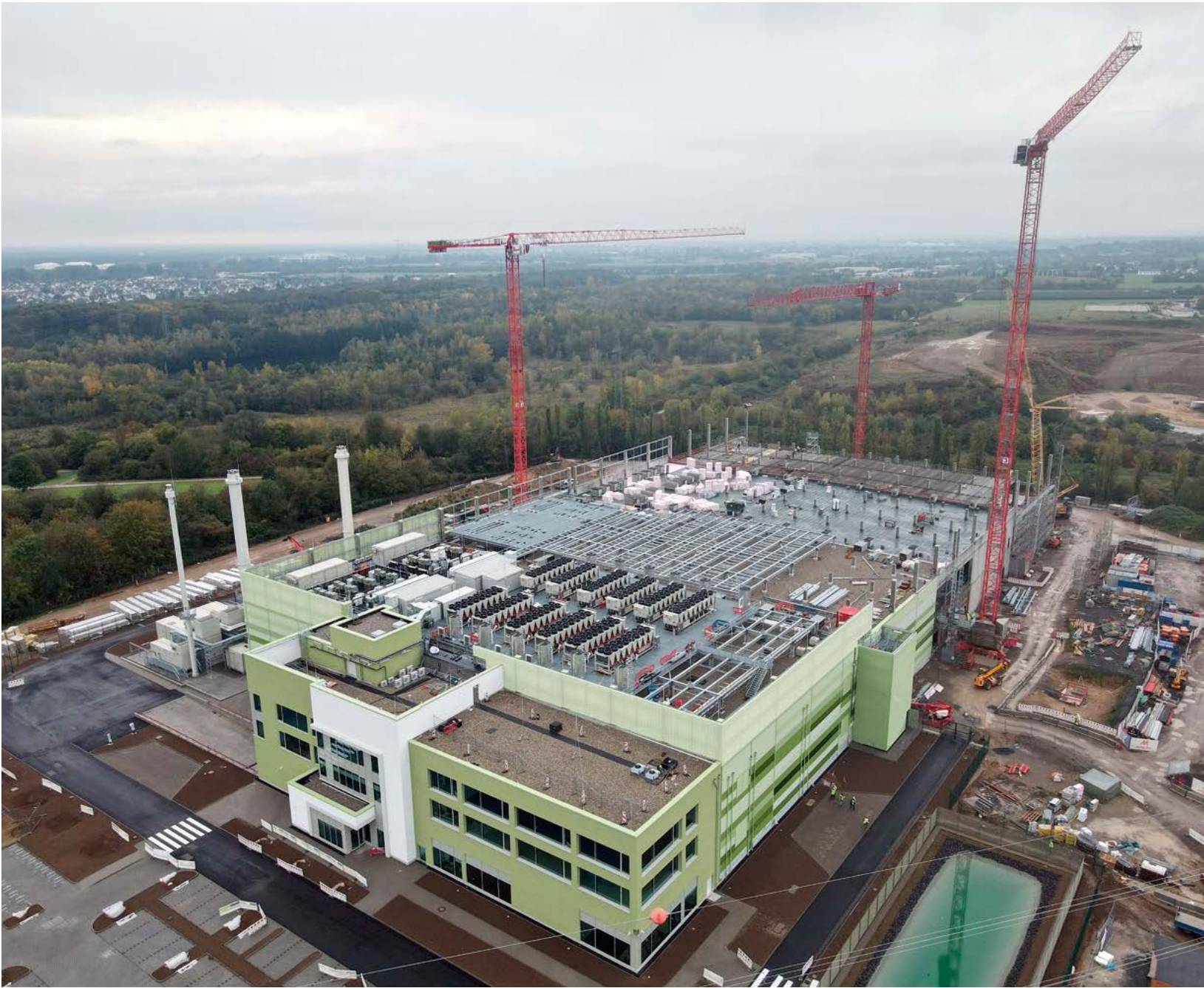
Aus der Vogelperspektive ist der sektionsweise Baufortschritt bei FRA33 deutlich zu erkennen. Das Rechenzentrum bietet nach dessen Fertigstellung 28.000 Quadratmeter IT-Fläche.
