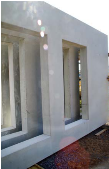
Die Massiv-Außenwände erfüllen die hohe Qualität der Sichtbetonklasse 3 Plus und warten auf ihren Einsatz.
