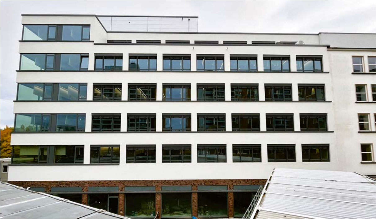
Die Architektur der Ergänzungsbebauung setzt die Linienführung des Bestandsgebäudes (rechter Bildrand) fort. Als Pendant zum Natursteinsockel des Mendelsohn-Baus wurde das Erdgeschoss mit Klinker verkleidet.
