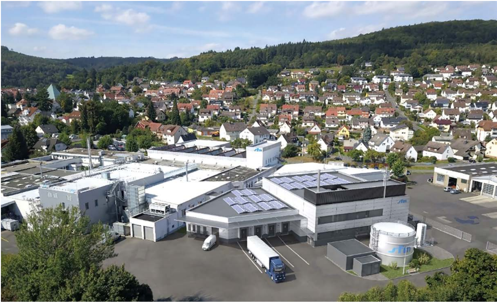
Mit der Errichtung des neuen Sterilisationsgebäudes (Werk 2) wird das Betriebsgelände in nördlicher Richtung erweitert. Gleichzeitig entsteht ein neues Logistikgebäude, das Werk 1 und Werk 2 zentral verbindet.
