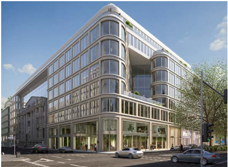
Bei der Revitalisierung bleibt ein großer Teil der bestehenden Substanz aus den 80er-Jahren erhalten – gut zu sehen an der in den Neubau integrierten denkmalgeschützten Fassade. Visualisierung © Hines
