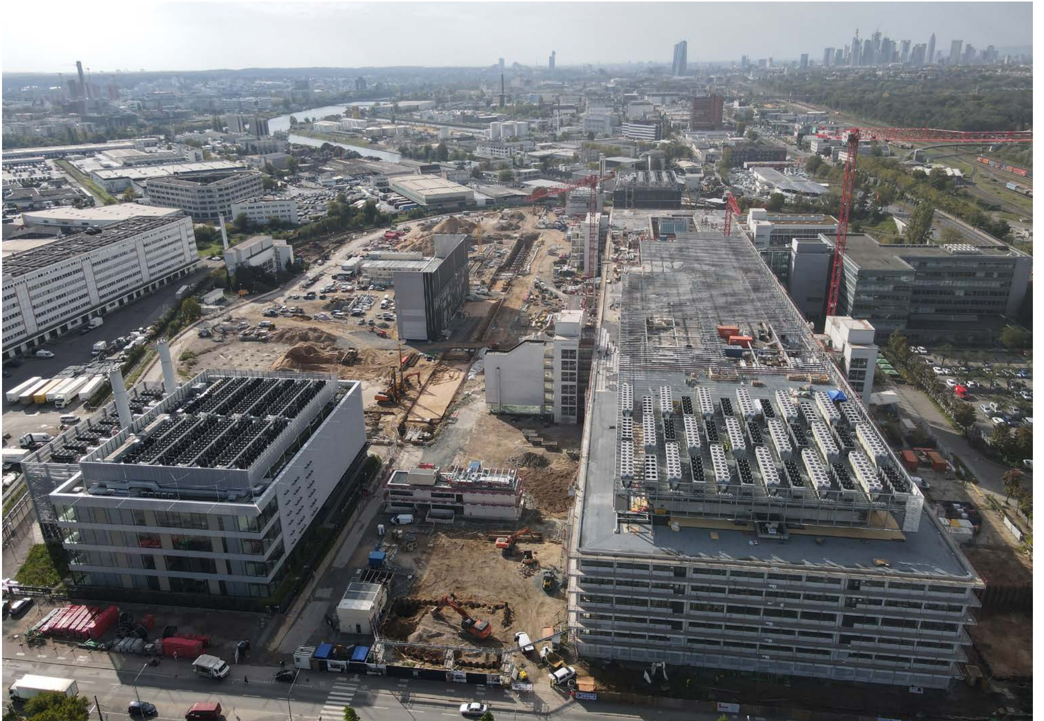
Auf dem ehemaligen Neckermann Gelände entsteht der Digital Park Fechenheim. Die Umsetzung der für die Rechenzentren benötigten Infrastruktur erfordert vom Baustellenteam ein hohes Maß an Koordination.
