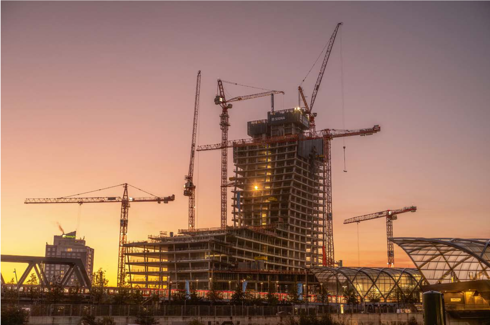
Perfekt von der aufgehenden Sonne angestrahlt, macht der Rohbau des Elbtowers mit über 100 Meter Höhe schon jetzt mächtig Eindruck in der Hamburger Hafencity.
