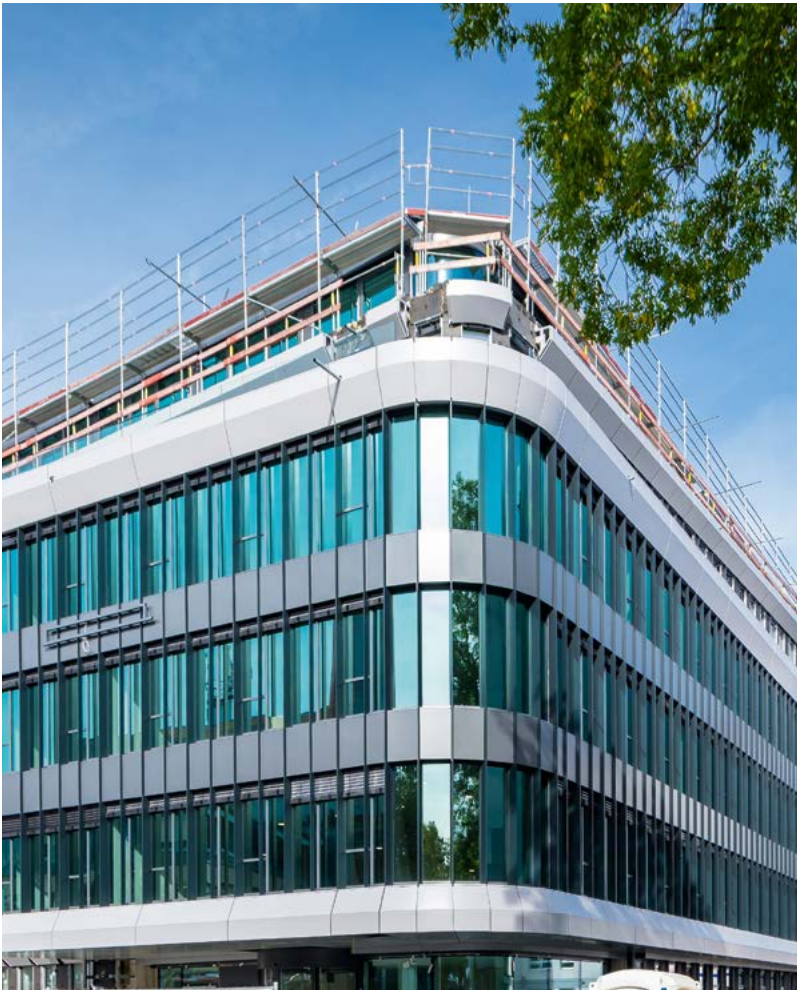
Das Bürogebäude Seilerbahn wird der neue Blickfang innerhalb Hofheims. Während Lupp in der Arge die Tief- und Hochbauarbeiten sowie den Innenausbau durchführte, zeichnete sich unser Partner, die Firma Lauer, für die Haustechnikgewerke verantwortlich.
