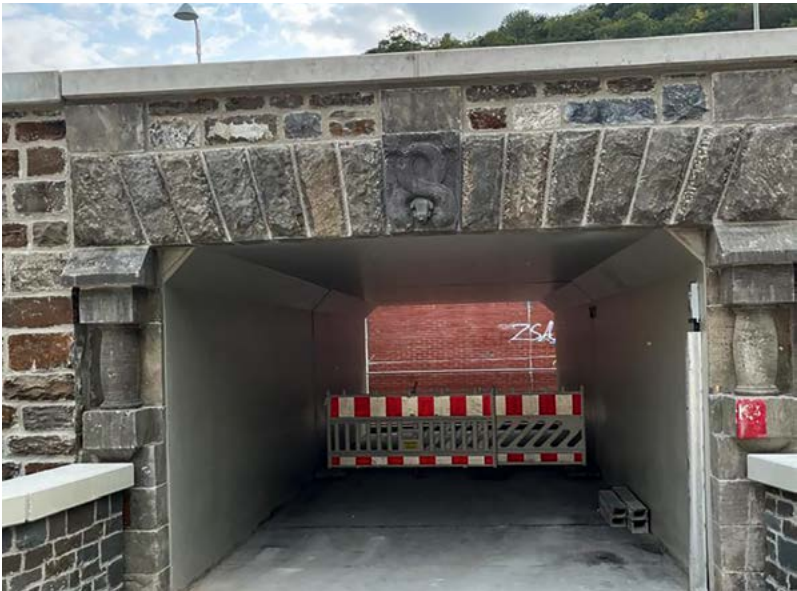
Bad Ems: Der Neubau wurde mit den erhaltenen Natursteinen verkleidet.
