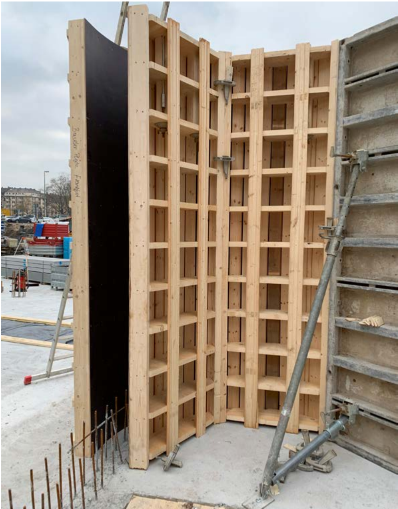
Bei welchem Bauvorhaben diese Sonderschalung zum Einsatz kam, verrät die seitliche Beschriftung mit Baseler Platz. Für das Kreisler und dessen geschwungene Form wurden mehrere solcher runden Ecken erstellt.
