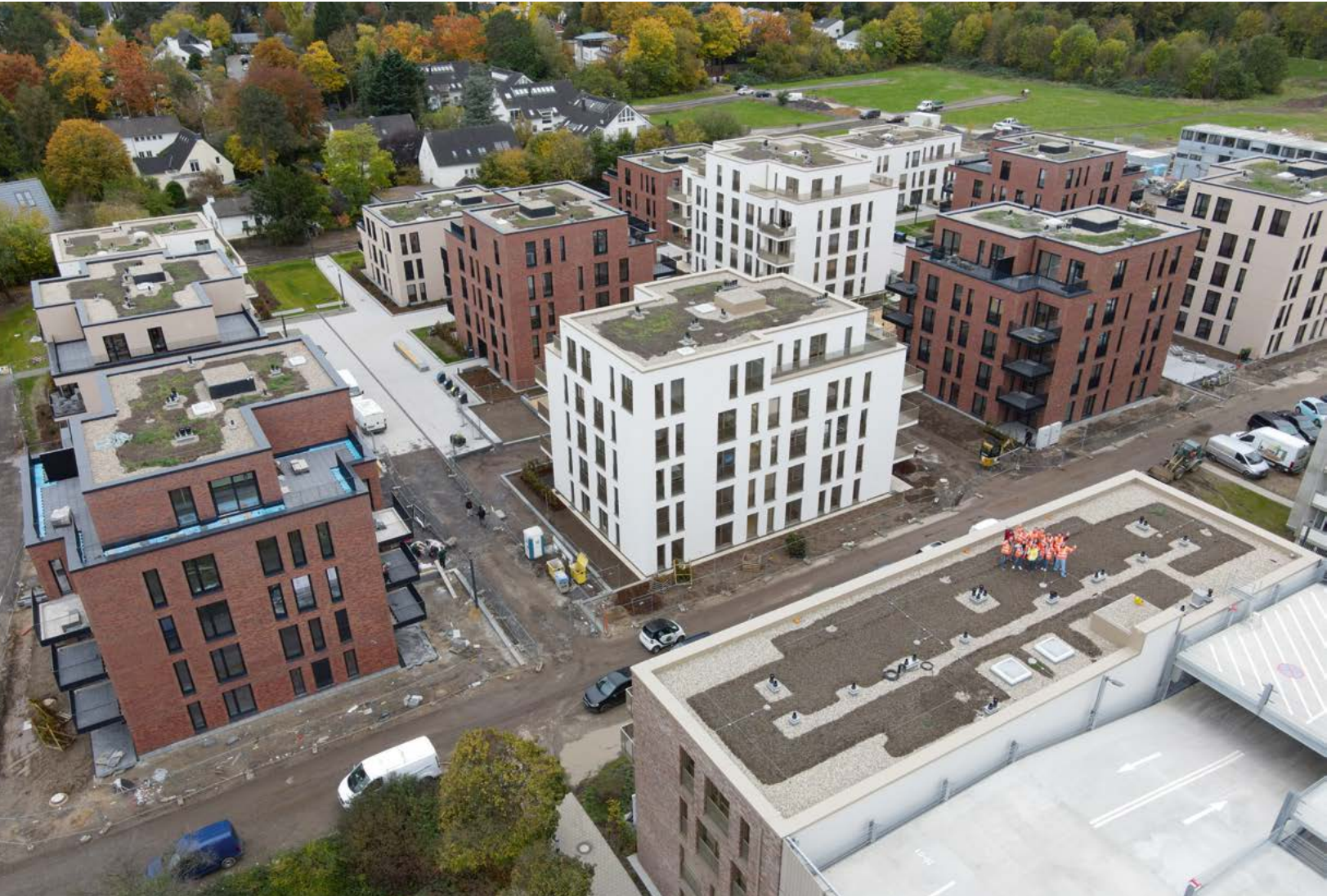
Die 164 Wohneinheiten des fertiggestellten Quartiers Hohenlind wurden größtenteils bereits bezogen. Vom Dach des viergeschossigen Apartmenthauses (vorn rechts) hat das Lupp-Team einen guten Überblick über das erfolgreich umgesetzte Projekt.
