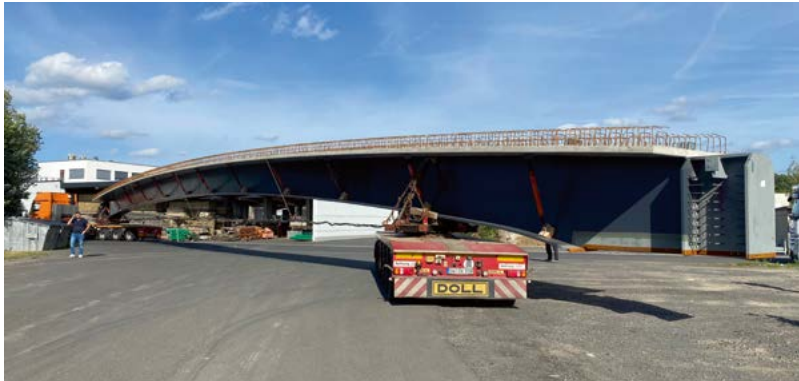
Die 54 Meter langen und bis zu 87 Tonnen schweren Stahlverbundträger wurden mittels Spezialtransportfahrzeugen im OSW-Werk in Nidda Harb abgeholt und nach Luxemburg transportiert.
