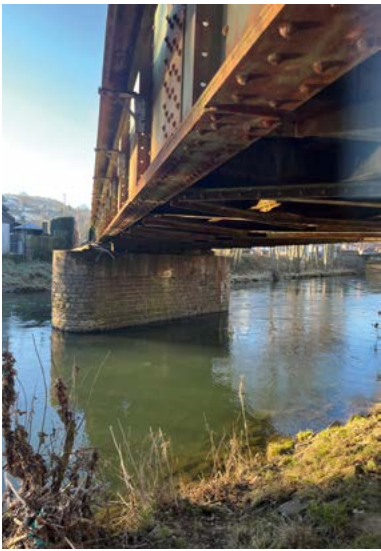
Engelskirchen: Eine Stabbogenbrücke soll die alte EÜ ersetzen.
