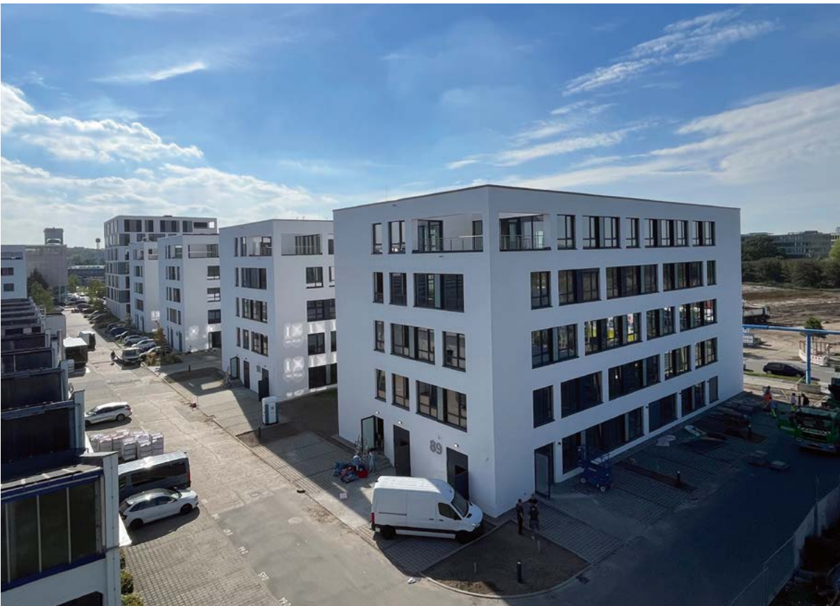
Zu den in der Hermann-Dorner-Allee von Lupp errichteten Gebäuden gehört auch der Neubau B8. Eingebettet zwischen B9 (im Vordergrund), B7, B6 und B5, dem Sitz der Berliner Lupp-Niederlassung, verfügt das Solitärgebäude über eine Gesamt-mietfläche von rund 2.300 Quadratmetern und wird noch bis Ende November 2023 ausgebaut.
