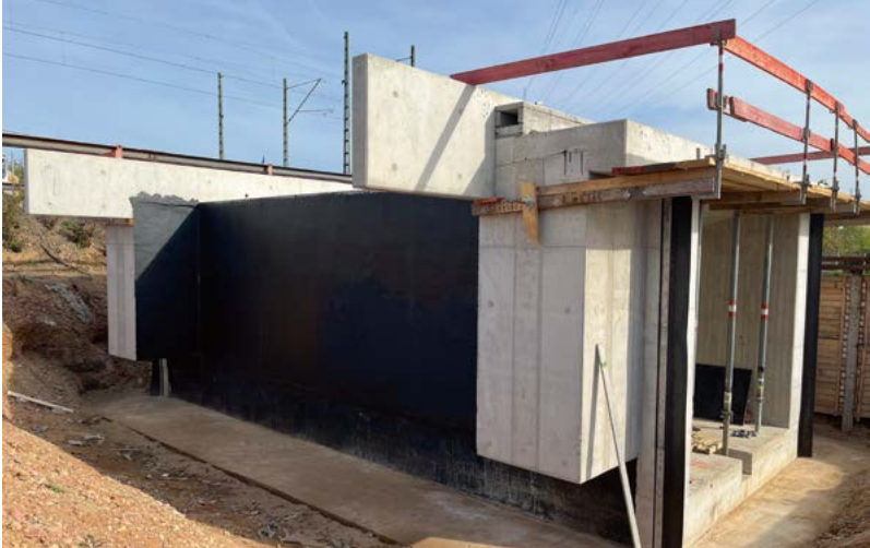
Karlstein: Die Personenunterführung wird neben der Bahntrasse errichtet.
