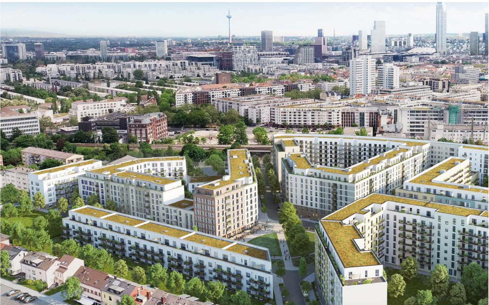
Die Arge Lupp/Streib errichtet die drei Bauabschnitte links vom zentralen Quartiersplatz mit 358 Wohnungen, einer KiTa sowie Gastronomieflächen.
