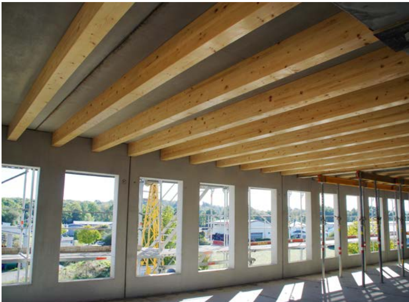
Mit den bereits montierten Holz-Beton-Verbunddecken wirkt das erste Obergeschoss des neuen Bürogebäudes schon sehr einladend.
