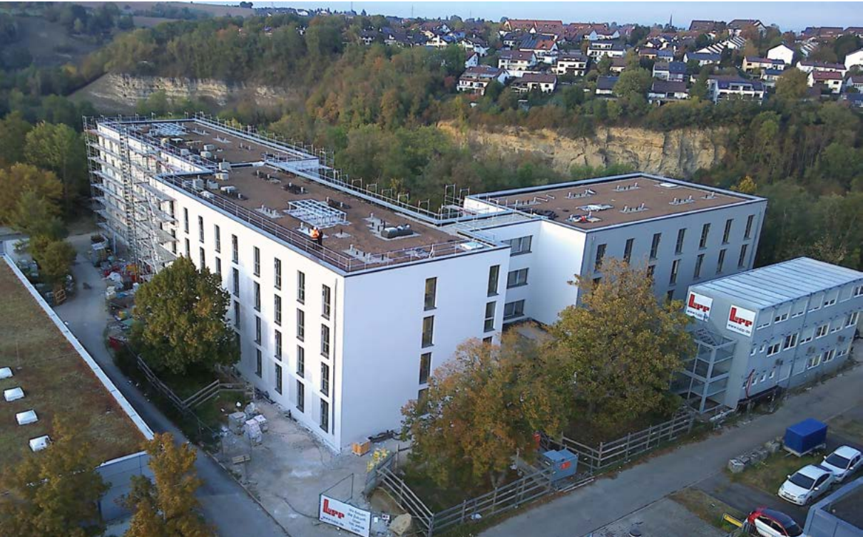
Der Ausbau der drei quaderförmigen Baukörper läuft derzeit auf Hochtouren. Im Vordergrund ist Bauteil A mit Blick auf den Haupteingangsbereich des neuen Jugendgästehauses zu sehen.
