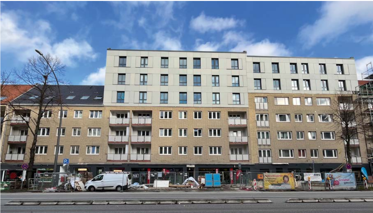
Das Bestandsgebäude in der Grindelallee wurde um drei beziehungsweise zwei Stockwerke mit 19 Wohneinheiten aufgestockt.
