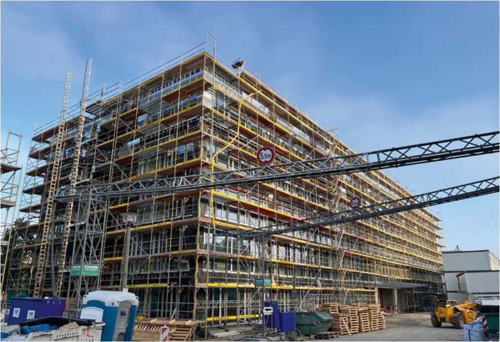
Der fertiggestellte Rohbau des sechsgeschossigen modernen Bürohauses (Bauteil A, links) wird noch mit einer Glasfassade versehen. Direkt daneben bei Bauteil B (rechts) laufen die Fassadenarbeiten sowie der Ausbau bereits seit Mai 2023.
