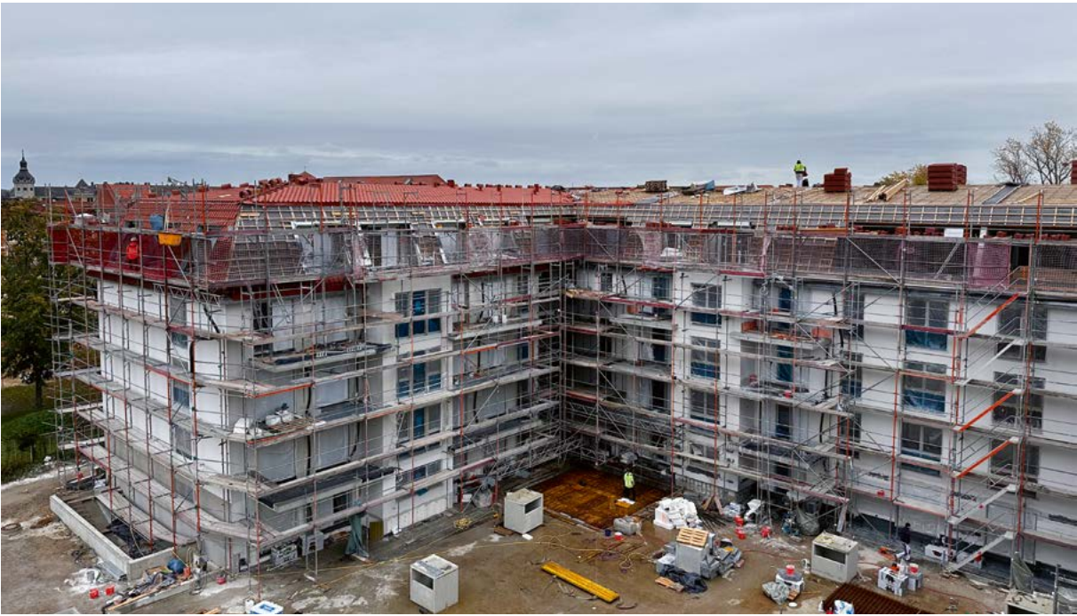
Mit der Wohnbebauung hans wird bereits das zweite Projekt der Riedberg III nach den aktuellen Standards des Gebäudeenergiegesetzes in Leipzig realisiert. Durch die Form des Mansarddaches lassen sich auch die Wohnflächen der Dachgeschosswohnungen optimal ausnutzen.
