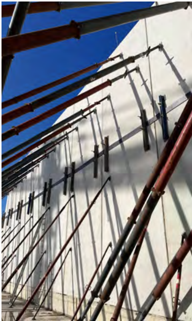
Die freistehenden Wände auf dem Dach des Umspannwerks werden bis auf elf Meter aufgestockt und mit bis zu 14 Meter langen Sprießen ausgesteift.
