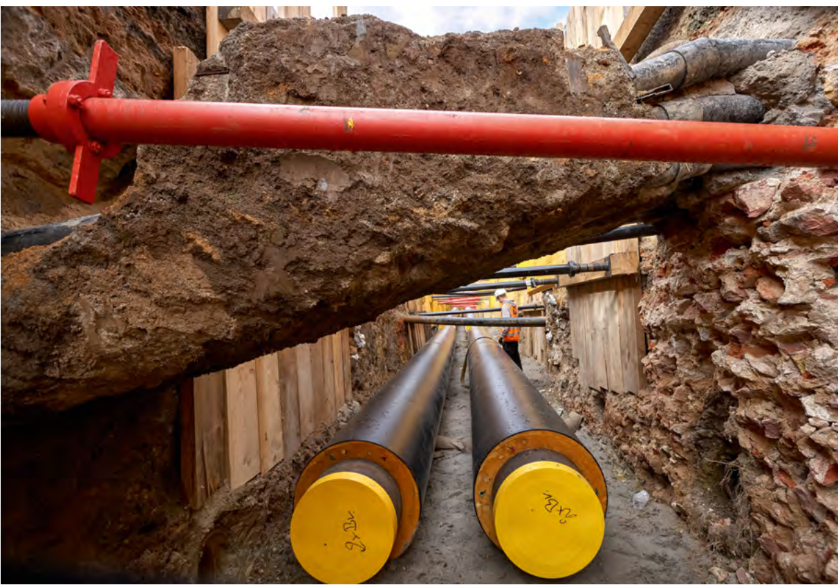
Mit Material aus England und Australien konnte sich das Projektteam behelfen. Die neue Fernwärmeleitung soll künftig das Fernwärme-Netz im Frankfurter Ostend unterstützen.
