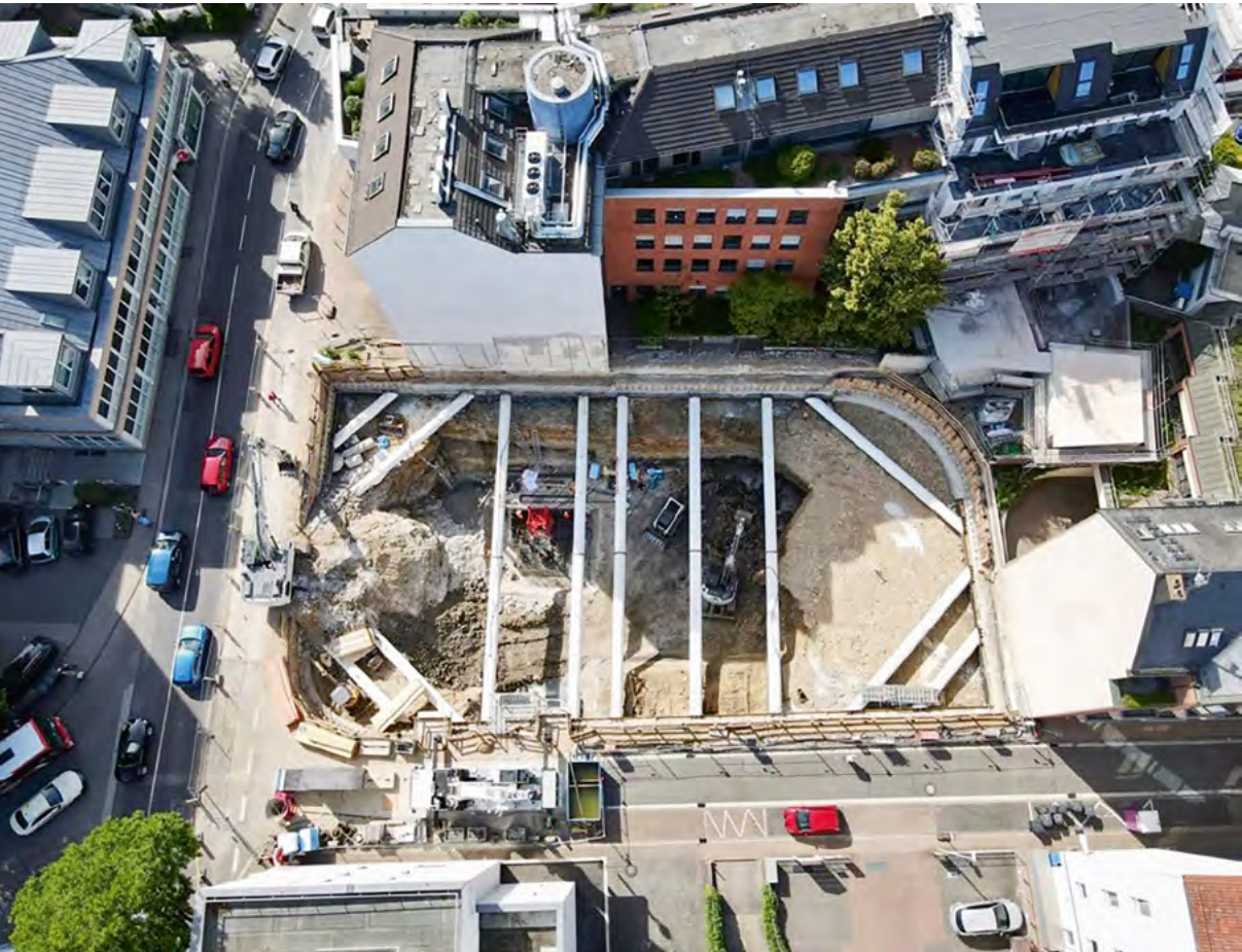
Links die umfunktionierte Fahrspur, unten die gesperrte Straße Seilerbahn: Aus der Vogelperspektive lassen sich die sehr begrenzte Baustelleneinrichtungsfläche sowie die mittlerweile rückgebaute Steifenlage zur Sicherung der Baugrube gut erkennen.
