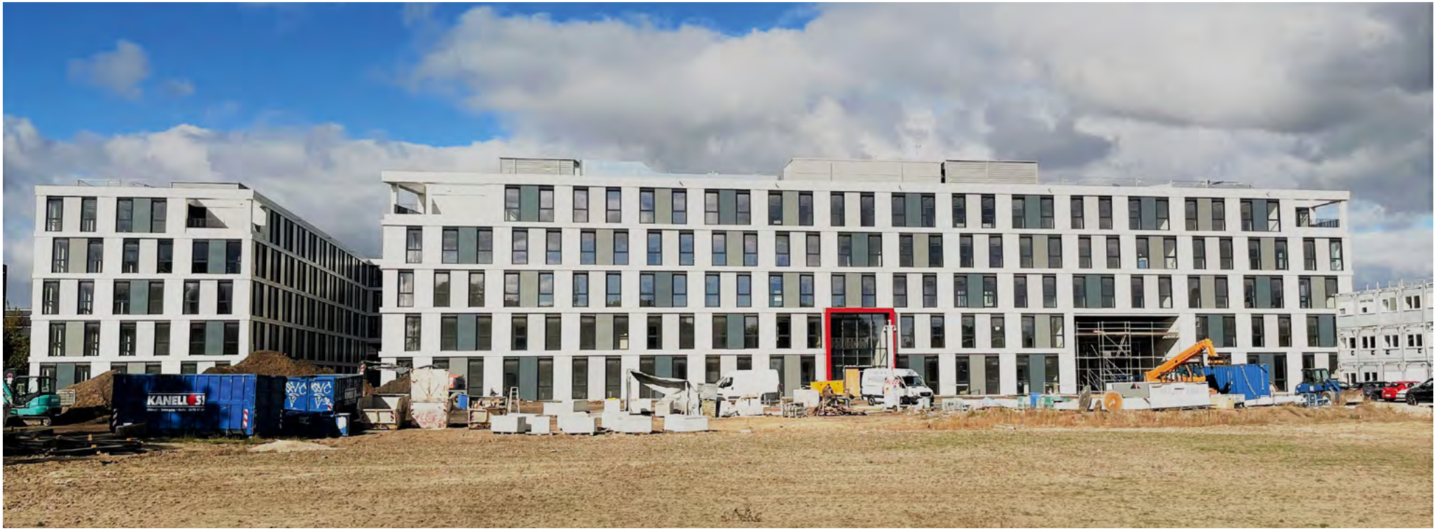
Der OfficeLab-Campus befindet sich an der Wagner-Régeny-Straße/Ecke Hans-Schmidt-Straße, in bester Lage direkt am S-Bahnhof Adlershof. Aufgrund dessen Anbindung an das Hochleistungsglasfasernetz mit 100 Gbit/s ist der Neubau bestens für digital-vernetztes Arbeiten geeignet.
