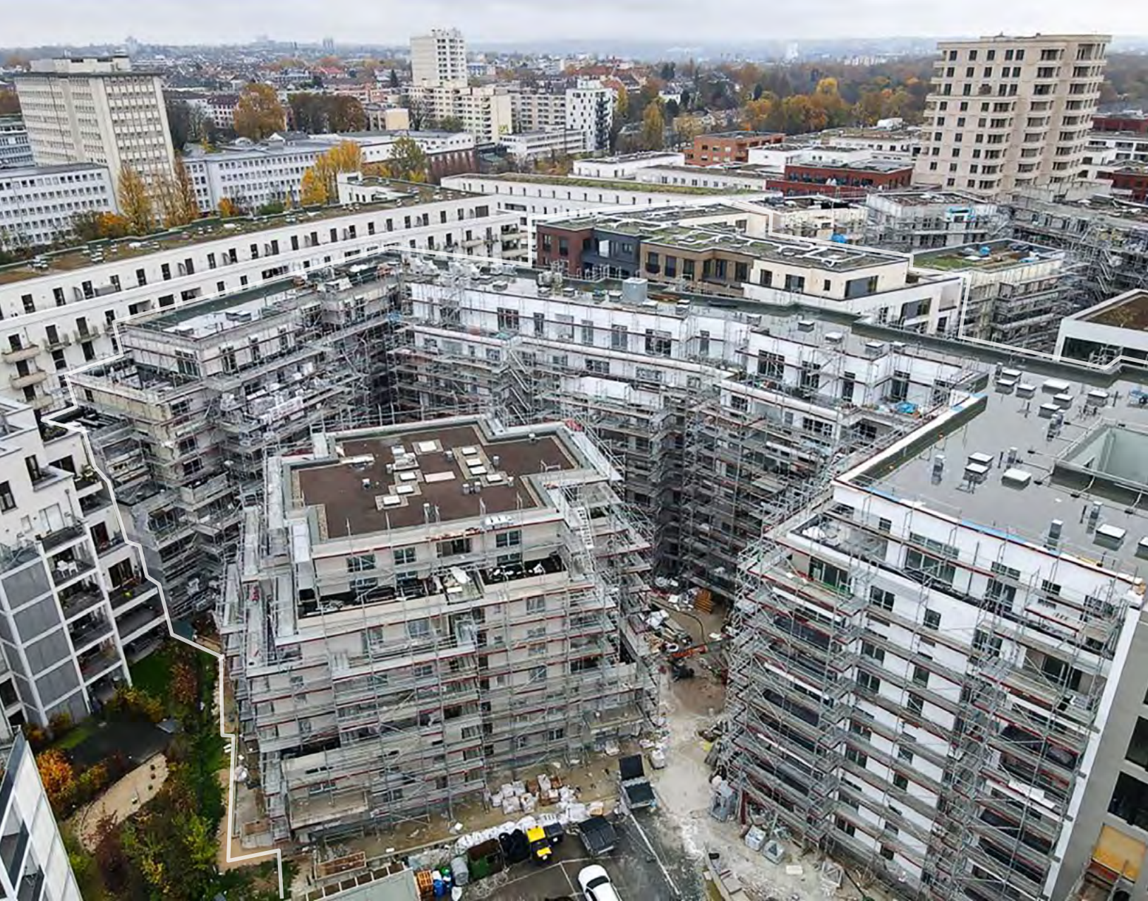
Die Bauarbeiten auf dem ehemaligen Mercedes-Areal im Ostend neigen sich dem Ende zu. Nachdem der OstStern Ost (im Hintergrund) wie geplant im Oktober 2022 an den Bauherren übergeben werden konnte, befindet sich auch der Ausbau von Bauteil West (im Vordergrund) voll im Zeitplan; einer Übergabe Mitte nächsten Jahres steht nichts im Wege.
