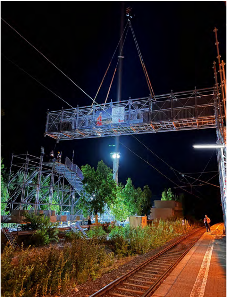
Mit einem 300-Tonnen-Autokran wird der längste der insgesamt drei Brückenträger eingehoben.
