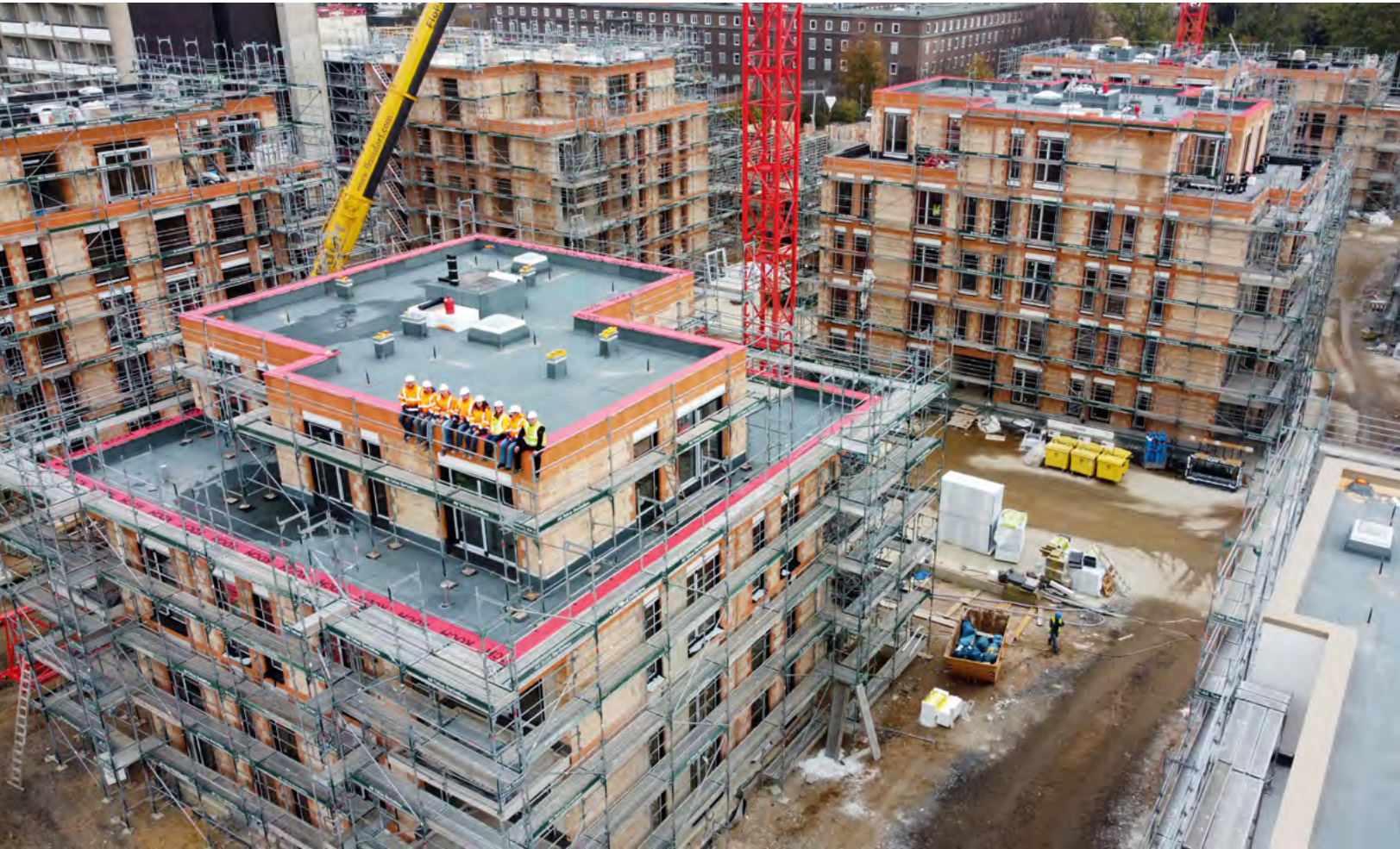
Die meisten Rohbauten sind fertiggestellt und das Quartier Hohenlind hat Form angenommen. Den Baufortschritt immer im Blick treibt das Lupp-Team derzeit die Ausbauarbeiten voran.
