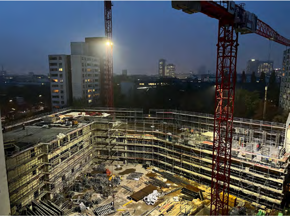
Der Ergänzungsbau mit sechs Obergeschossen und einem Untergeschoss fügt sich in die Blockrandbebauung ein und grenzt direkt an die benachbarten Gebäude. Nach Fertigstellung des Rohbaus soll Anfang 2023 mit den Ausbau- und Installationsarbeiten begonnen werden.
