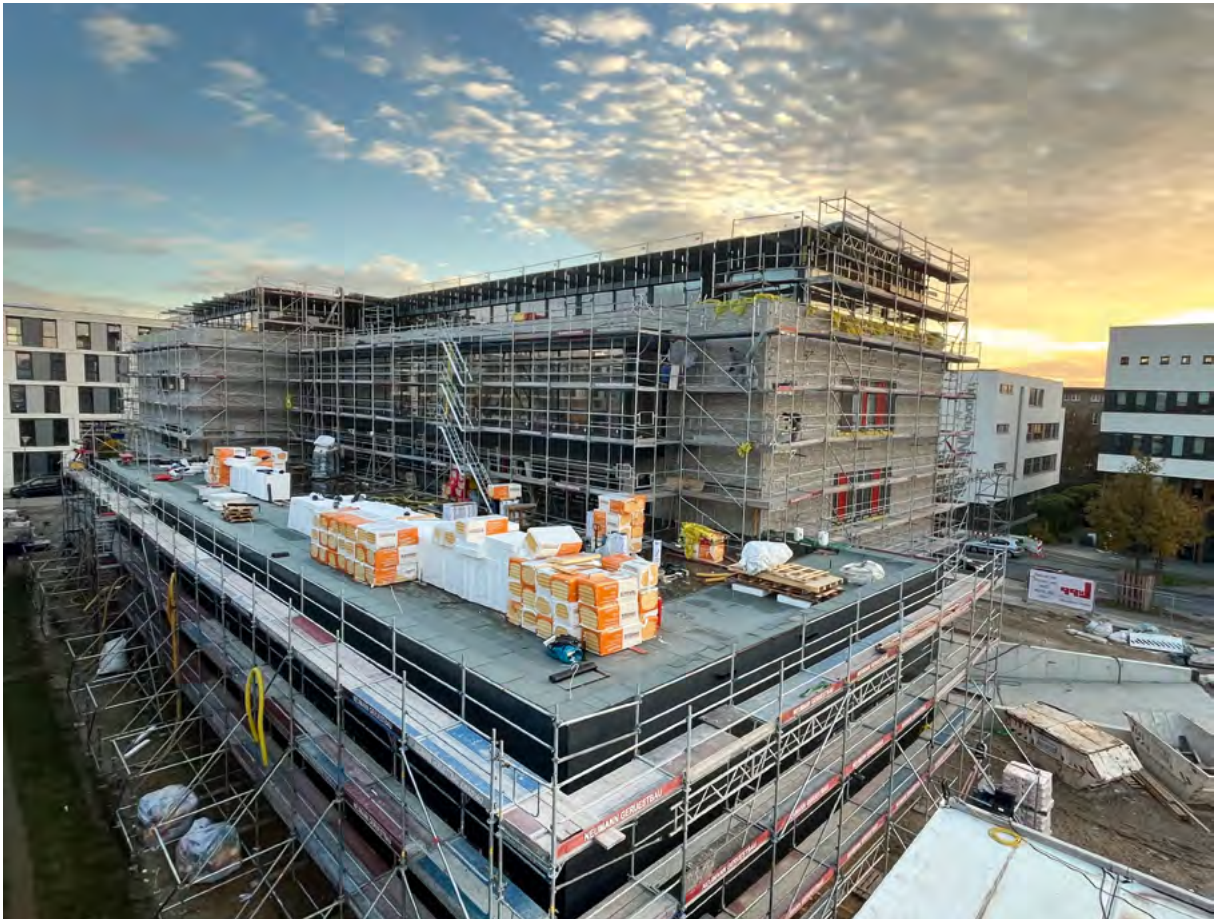
Die Arbeiten an der Gebäudehülle sind im vollen Gange und werden zum Ende des Jahres 2022 abgeschlossen.
