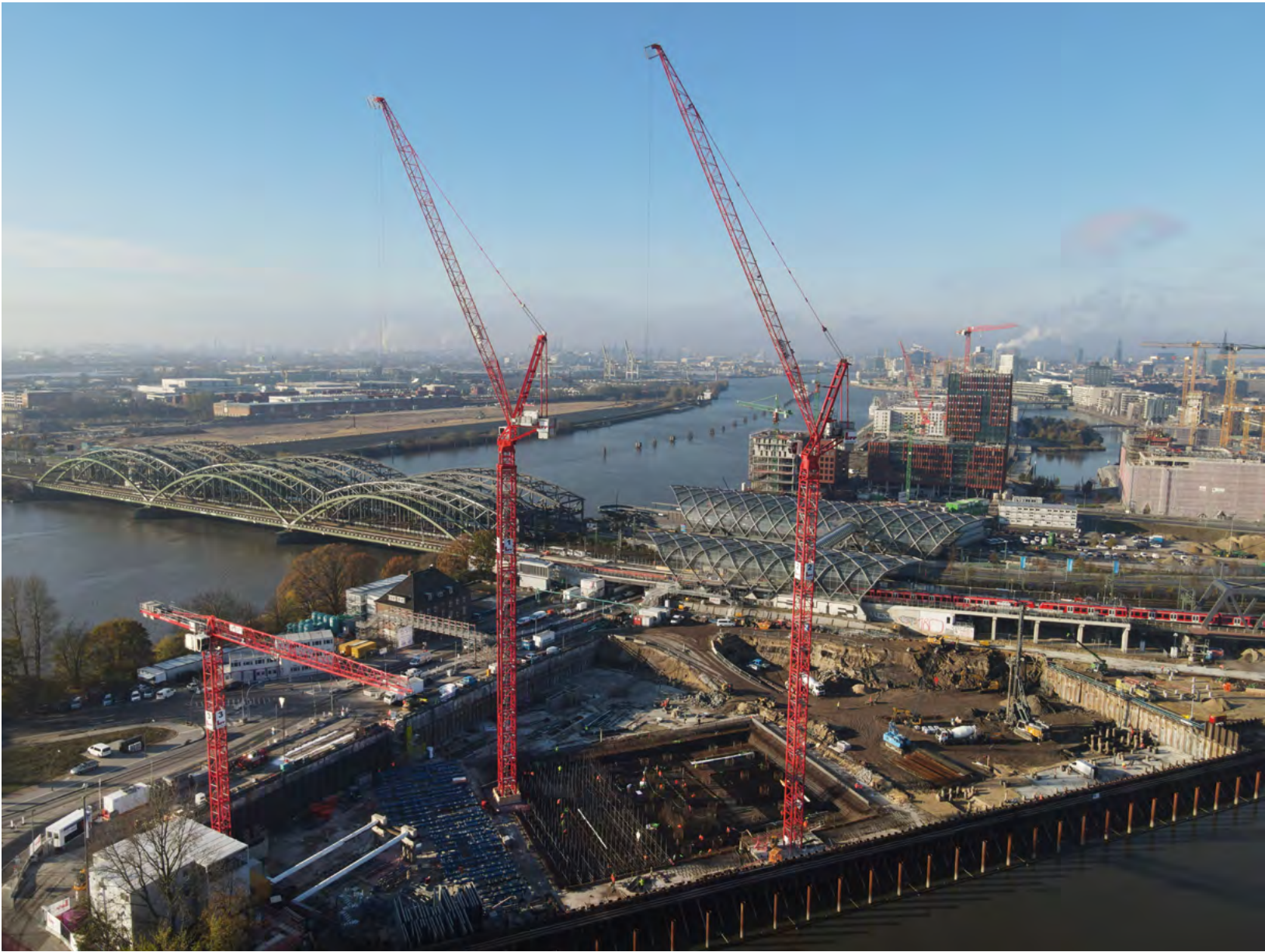
Lupp hat die Baustelle an der östlichen Spitze der HafenCity-Halbinsel bereits Anfang September 2022 übernommen. Zur Vorbereitung der 48-stündigen Großbetonage vor Weihnachten werden im Bereich der Hochhausplatte derzeit 3.500 Tonnen Betonstahl eingebracht
