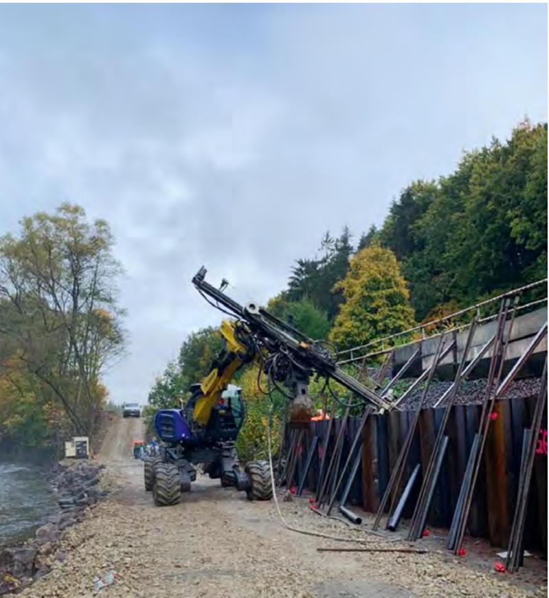
Auch bei den für die Rückverankerung von Kopfbalken sowie von Spritzbetonschalen notwendigen Bohrungen von Titanankern kam der Schreitbagger zum Einsatz.
