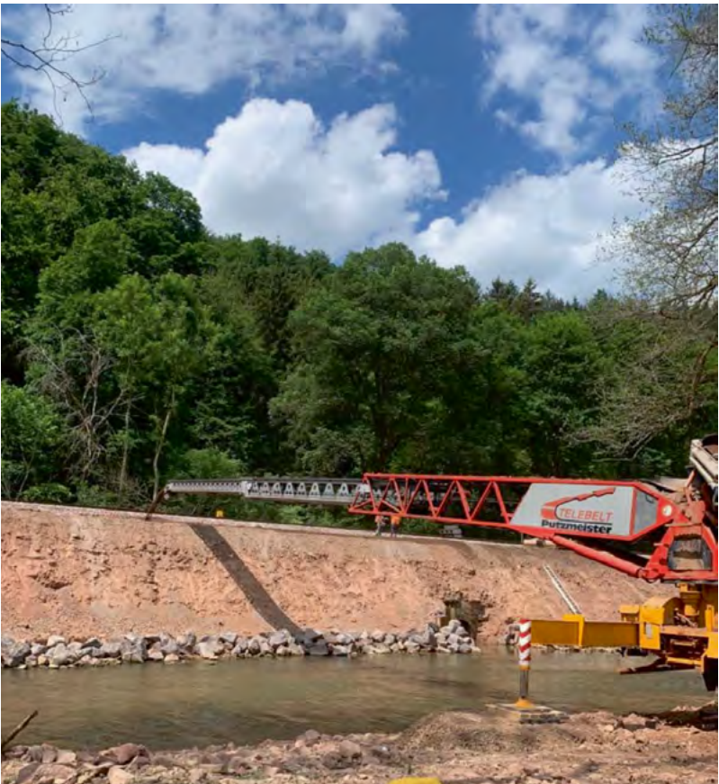
Der durch die Flut zerstörte Damm wurde auf 145 Meter Länge mittels HZV-Verfahren unter Verwendung des vorhandenen Aushubmaterials nachhaltig saniert.
