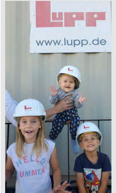
Die Zwischenbauabnahme bei dem Besuch auf der Baustelle EOS Oberursel Anfang September verlief reibungslos. Johanna (7), Marie (10 Monate) und Arthur (4) Naumann hatten keinerlei Beanstandungen, obgleich akribisch geprüft wurde.
