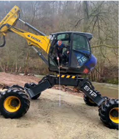
Für sicheres und effektives Arbeiten an den steilen Böschungen hat sich ein Schreitbagger bewährt.
