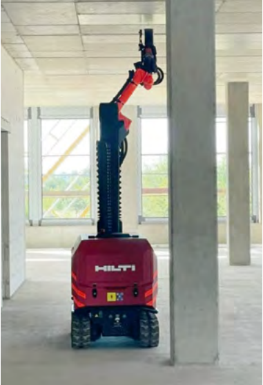
Ferngesteuert fährt der kleine, rote Roboter auf Raupenketten an den richtigen Platz im Gebäude. Dort führt er Stück für Stück die ihm übertragenen Bohraufträge aus und markiert sie für die verschiedenen Gewerke.
