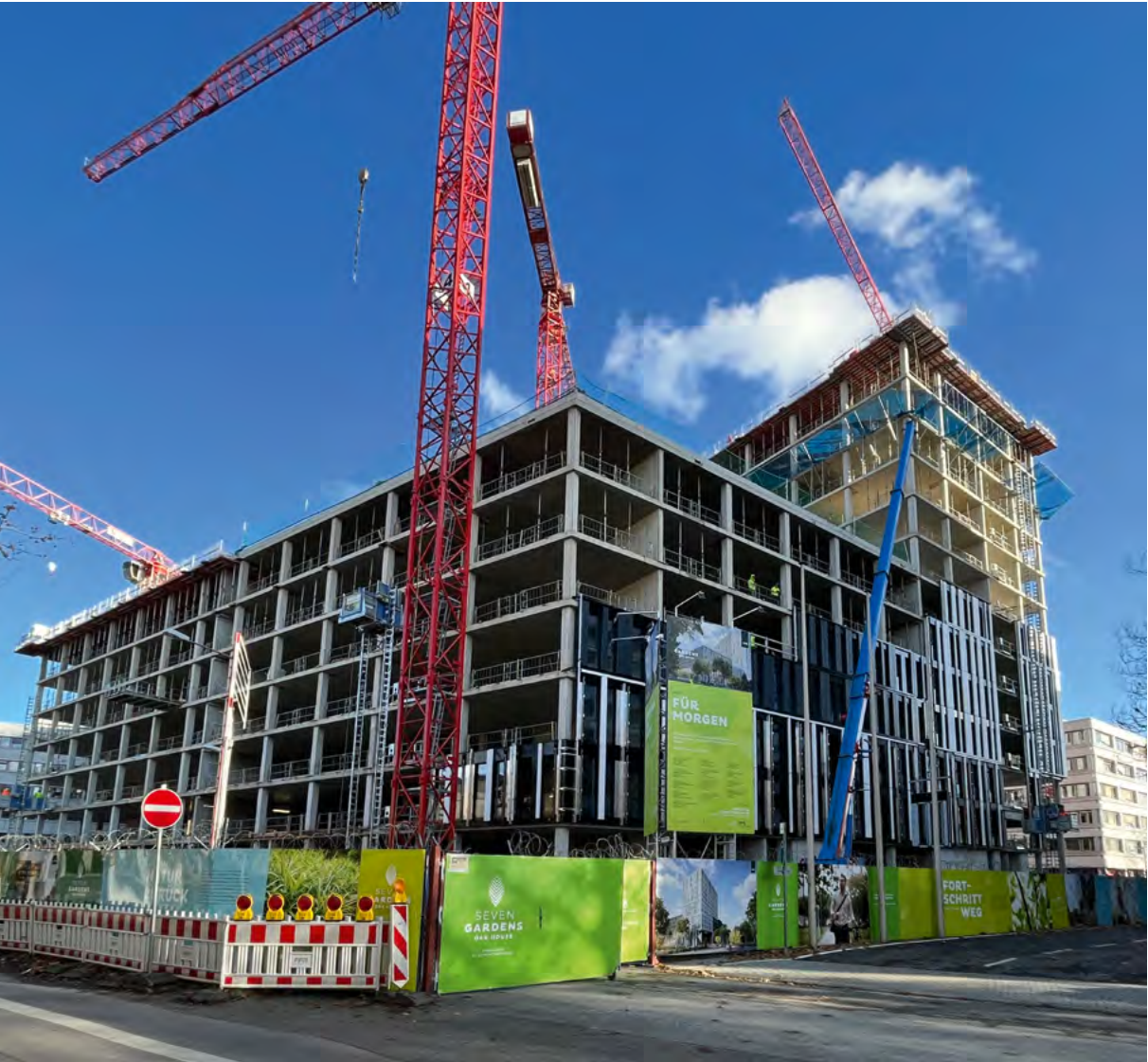
Als ersten von sieben Baubschnitten baut Lupp derzeit das Oak House. Mit ca. 34.000 Quadratmeter Mietfläche wird es verschiedenen hessischen Ämtern und Behörden als neuer Hauptstandort dienen.
