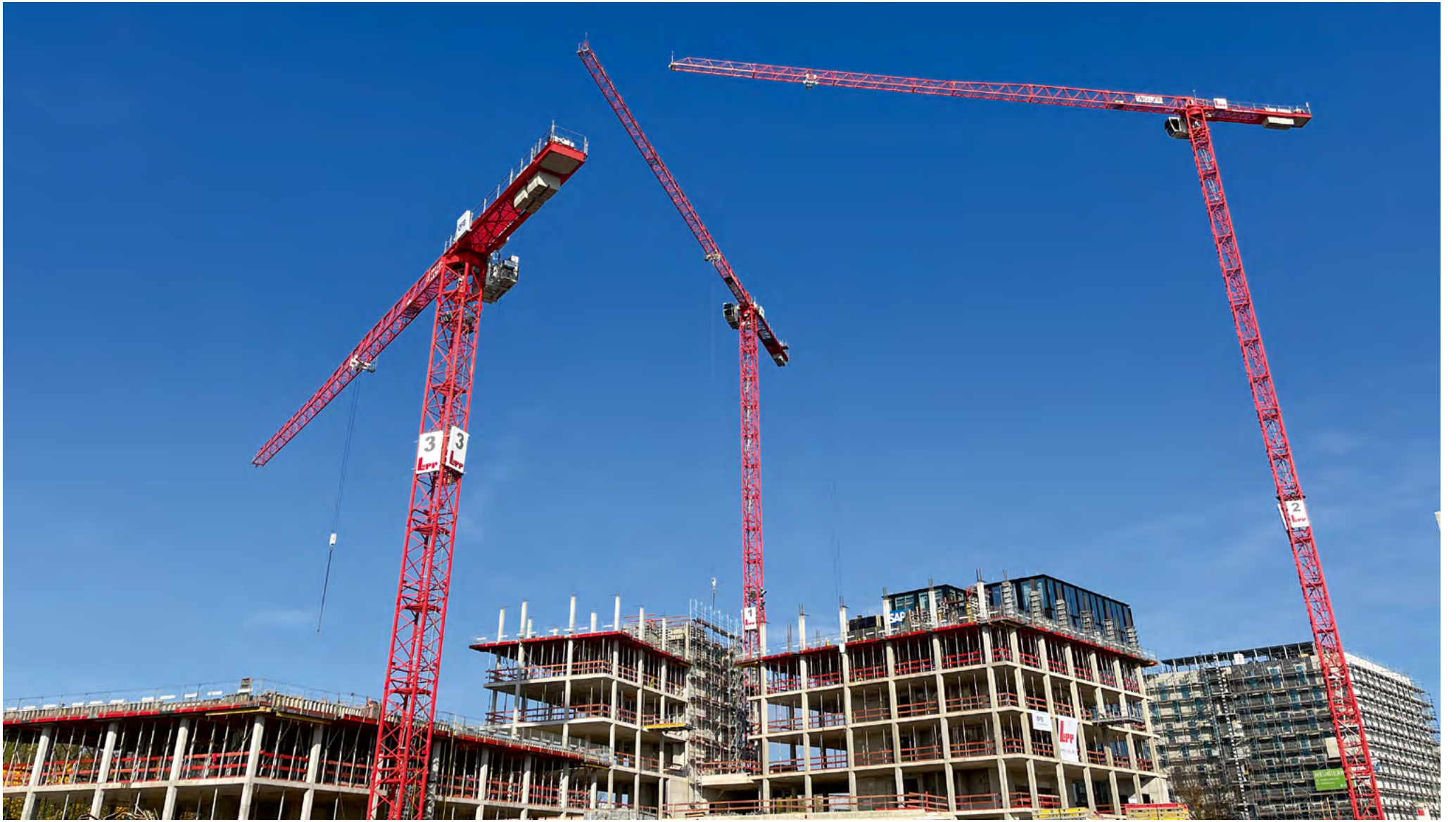
Der Rohbau des Eschborn Gate soll bis auf die letzten Geschosse beim Hochhaus bis zum Jahresende 2022 fertiggestellt werden. Noch vor dem Ende der Rohbauphase will die Arge mit den Fassadenarbeiten sowie mit dem Ausbau beginnen.
