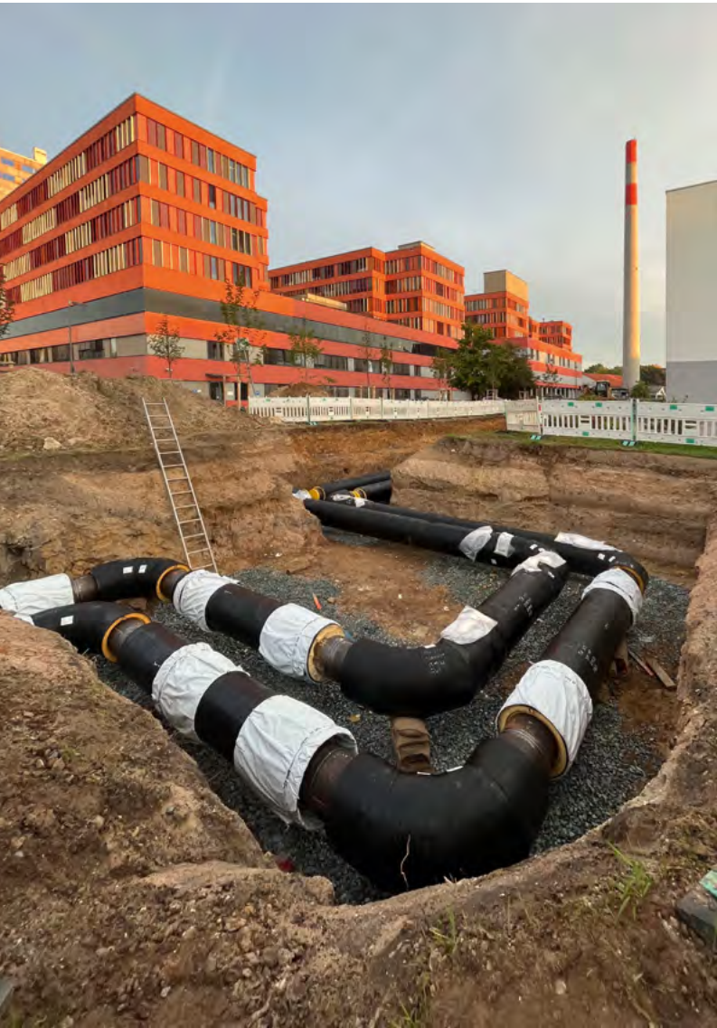
Die vormontierten und vorisolierten Dehnbögen der Fernwärme DN 400/560 wurden in den Rohrgaben abgelassen und zwischen neuer und bestehender Leitung eingeschweißt.
