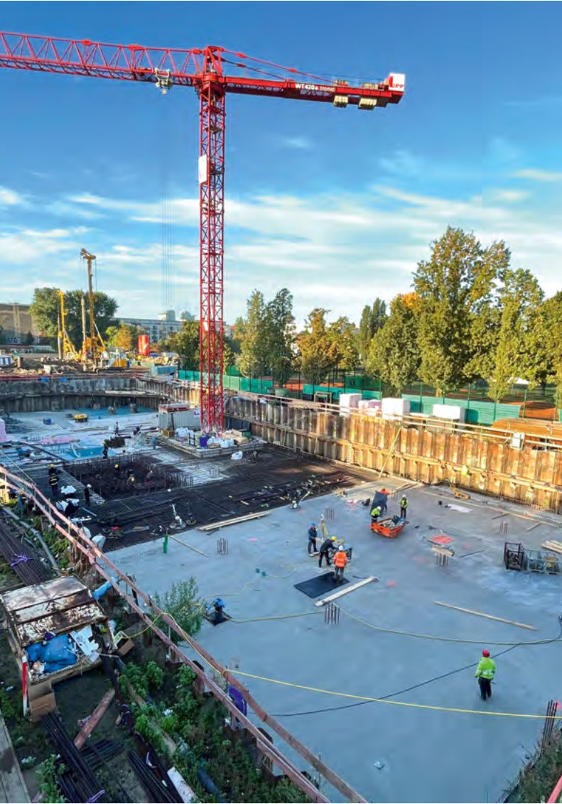
Nach dem verzögerten Baustart sind die Rohbauarbeiten für die Bodenplatte von Ostkreuz Campus B in vollem Gange, während im Hintergrund die Erdbauarbeiten für Ostkreuz Campus A zu sehen sind.
