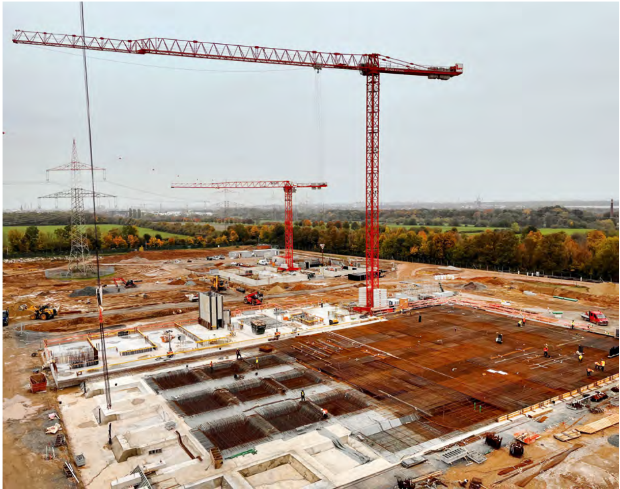
Die Arbeiten an der Bodenplatte für FRA33 kommen gut voran. Das Rechenzentrum bildet den Anfang des in den nächsten Jahren entstehenden Digital Park Hattersheim. Im Hintergrund zu sehen: das Lupp-Projekt Digital Reality Umspannwerk Syna.
