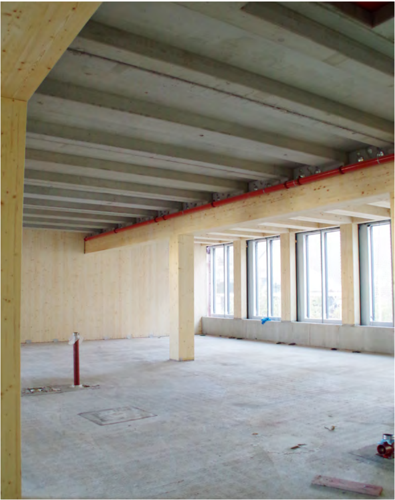
Die bei Timber Pioneer eingebauten Holz-Beton-Verbund-Decken und Sichtbeton-Fertigteil-Rippendecken verfügen über eine hohe Traglast und Biegesteifigkeit bei verhältnismäßig geringem Eigengewicht und relativ niedriger Gesamthöhe.
