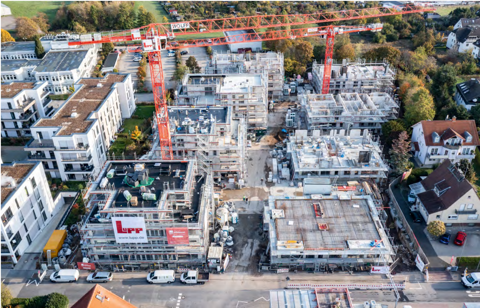
Aus der Luft lässt sich gut erkennen, wie weit die Arbeiten an den einzelnen Mehrfamilienhäusern in Oberursel bereits vorangeschritten sind. Während sich ein Teil der Häuser noch in der Rohbauphase befindet, läuft in einigen bereits der Ausbau.
