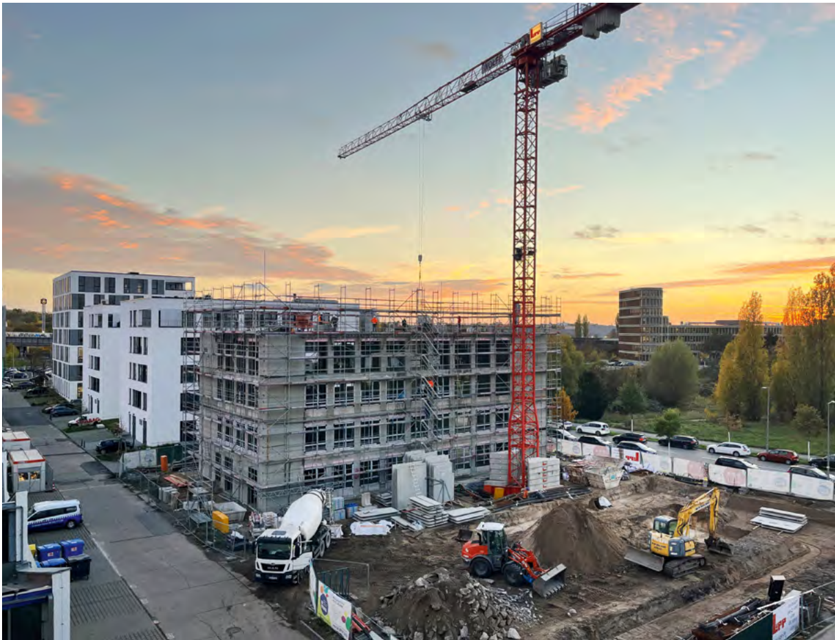
Bis auf einige Ortbeton-Elemente werden die Gebäude größtenteils aus Stahlbeton-Fertigteilen ausgeführt, wodurch sich die Rohbauzeit auf etwa vier Monate verkürzt. Der Rohbau von B8 befindet sich Ende Oktober 2022 auf der Zielgeraden.
