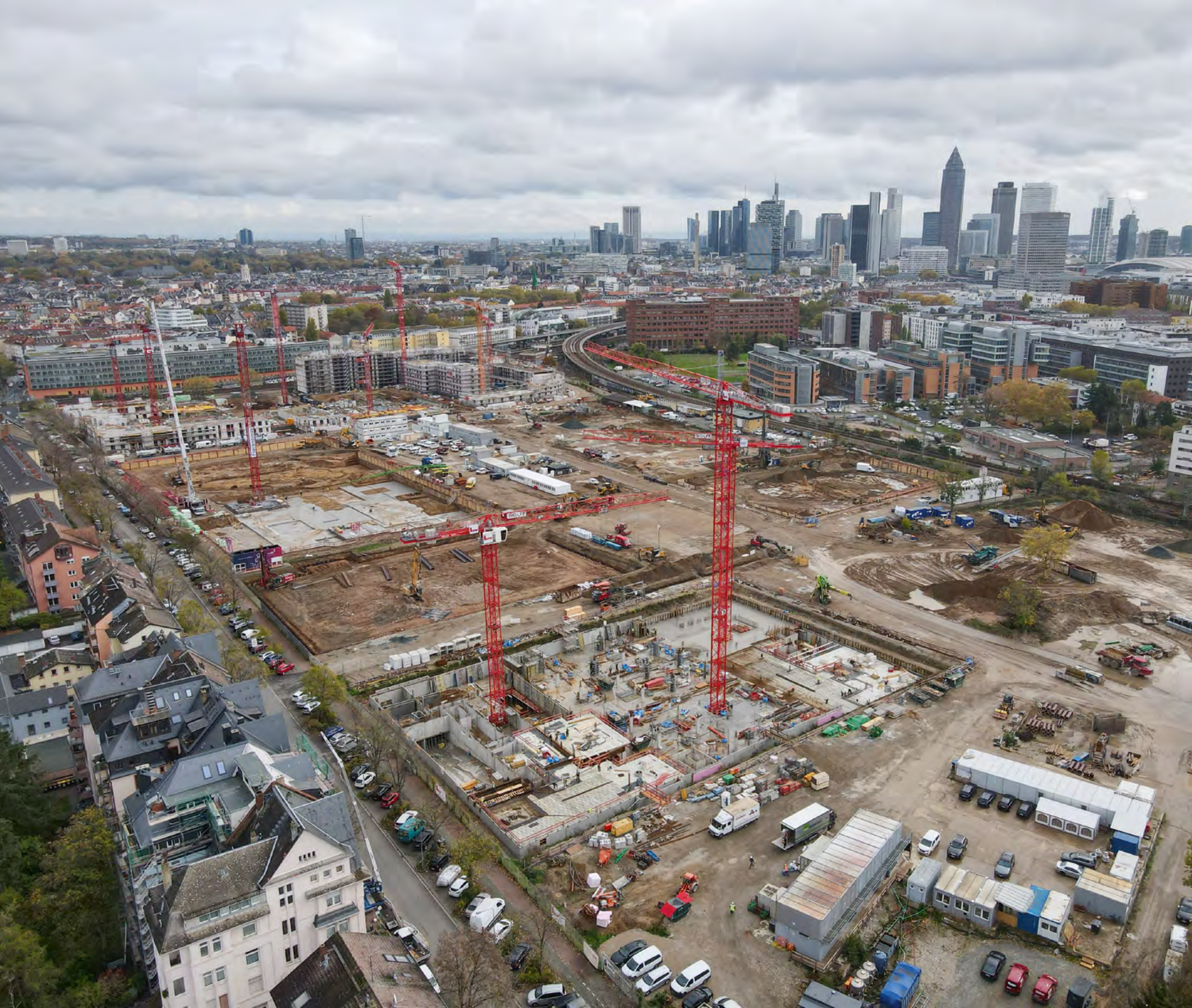
Das Schönhof-Viertel ist derzeit eine der größten Wohnprojektentwicklungen in Frankfurt. Die Unternehmensgruppe Lupp ist hier auf dem Baufeld B (im Vordergrund) allein und in Arge auf den Baufeldern C2 und C3 (in der Mitte links) sowie auf E2 und D3 (hinten rechts) aktiv.
