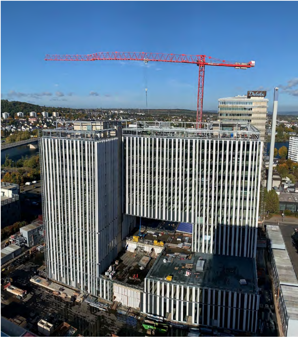
Besonders markant an der neuen Debeke-Hauptverwaltung ist ein rechteckiges Tor im Gebäudevolumen des Neubaus. Hierfür mussten drei Verbund-Stahlträger mit 30 Meter Länge von einem Spezialkran an ihren Platz gebracht werden.
