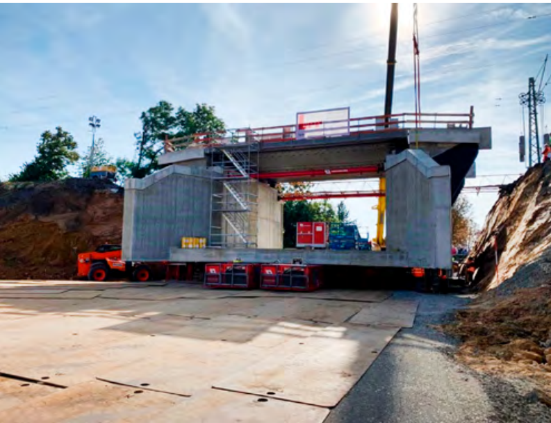
Assenheim: Mit SPMT-Fahrzeugen wurde der neue Überbau eingefahren.
