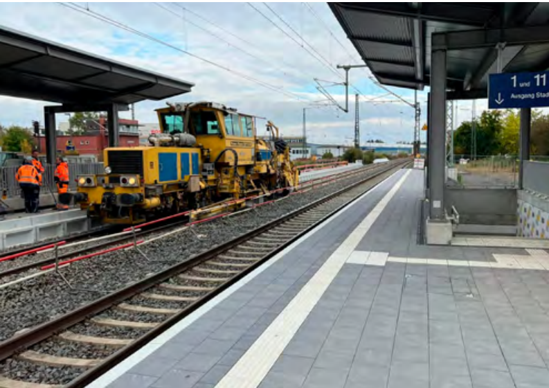
Lollar: Der angehobene neue Bahnsteig erleichtert den Zugang zum Bahnverkehr.
