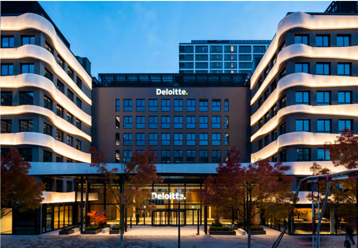
Dass Zebras auch nachtaktiv sind, wird auf der Europaallee eindrucksvoll bewiesen. Mit den beleuchteten Streifen ist der Neubau auch im Dunkeln leicht zu erspähen.
