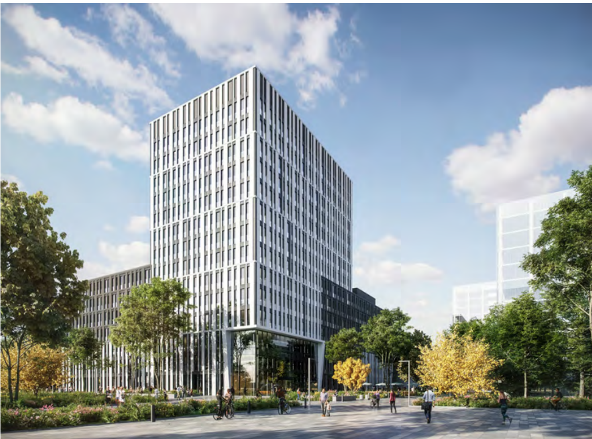
Im Auftrag der OFB Projektentwicklung baut Lupp am Wiesbadener Behördenstandort Schiersteiner Berg ein nachhaltiges Bürogebäude. Die Planungen des Architekturbüros KSP Engel sehen ein Hochhaus mit 14 Geschossen eingebunden in einen siebengeschossigen Sockelbau mit begrüntem Innenhof vor.
