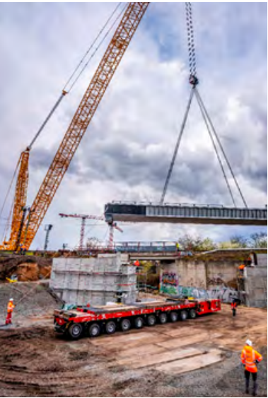
Hanau: Für den Einhub des Überbaus kam ein Raupenkran zum Einsatz.
