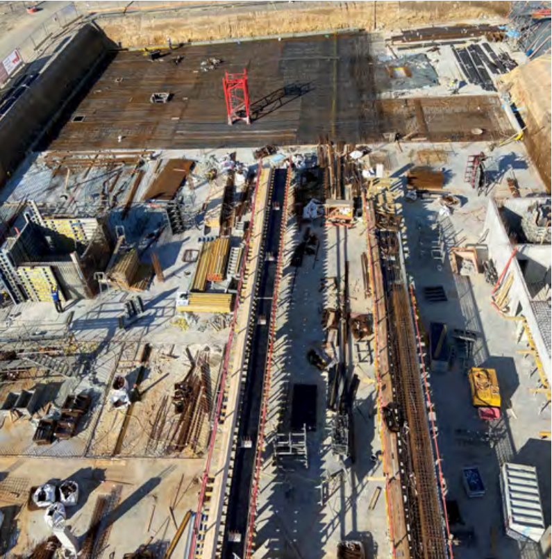
Seit dem Beginn der Bauarbeiten im Sommer 2021 ist der Baufortschritt im Heiligkreuzviertel bereits deutlich zu erkennen. Die Tiefgarage soll noch bis Ende des Jahres fertiggestellt werden.
