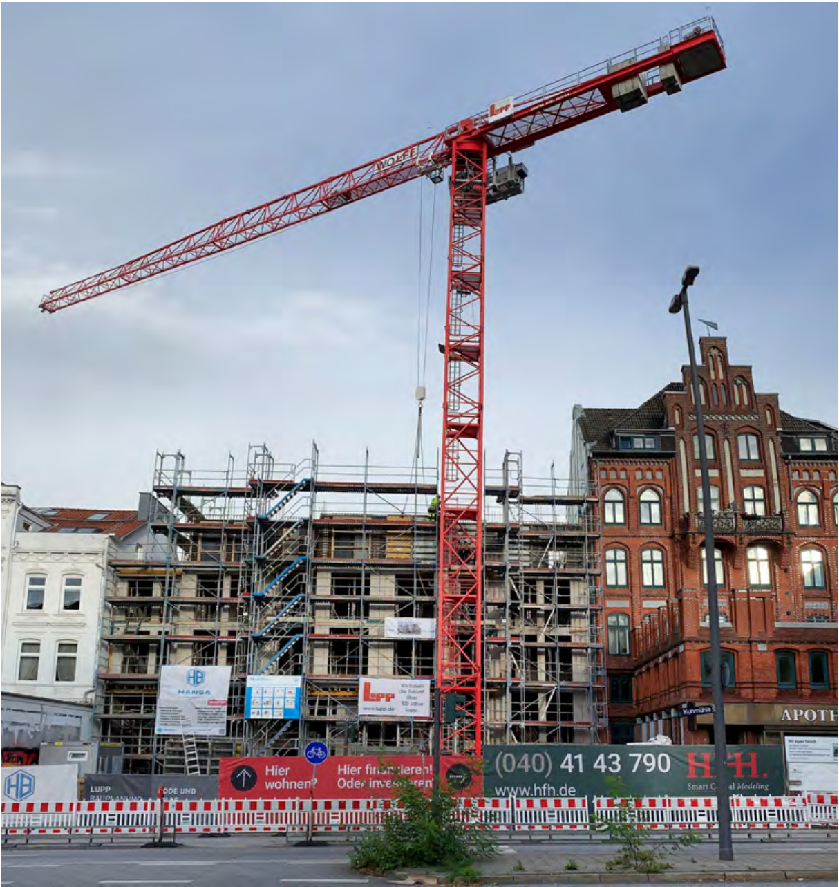
Der Blick von der Straße lässt die beengten Platzverhältnisse auf dem Baufeld erahnen. Das Foto zeigt die Einschalarbeiten der Außenwand im vierten Obergeschoss.
