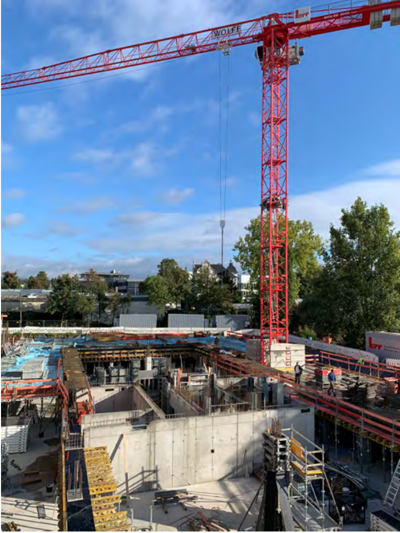
Derzeit führt das Baustellen-Team die Schal-, Bewehrungs- und Betonarbeiten für die Decke des ersten Untergeschosses durch. Noch bis Ende des Jahres soll das erste Obergeschoss im Rohbau fertiggestellt werden.
