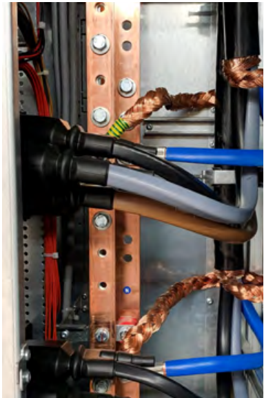
Am Stammsitz in Nidda können bis zu 60 E-Autos aufgeladen werden. Hierfür wurden drei mächtige Kabel von der Hauptverteilung zum Parkplatz verlegt.
