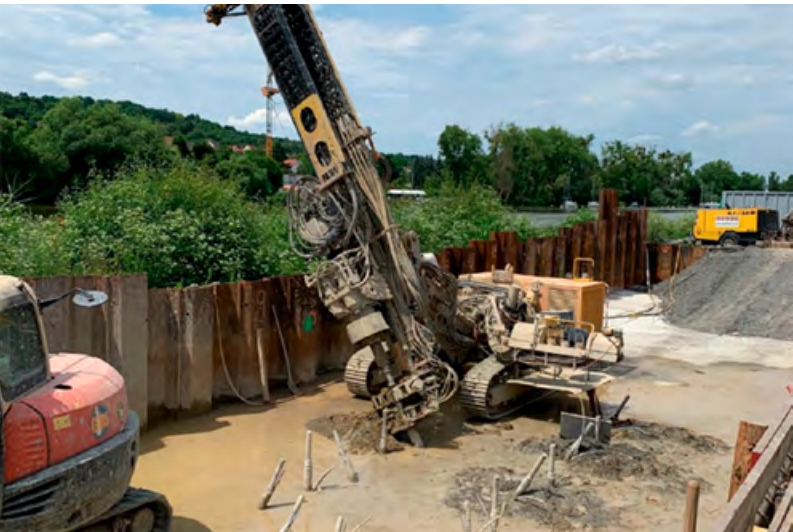
Veitshöchheim: Insgesamt wurden für das Bauwerk 256 Mikropfähle gebohrt.
