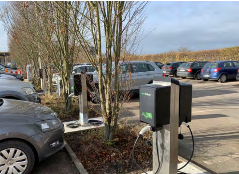
Am Stammsitz in Nidda können bis zu 60 E-Autos aufgeladen werden. Hierfür wurden drei mächtige Kabel von der Hauptverteilung zum Parkplatz verlegt.
