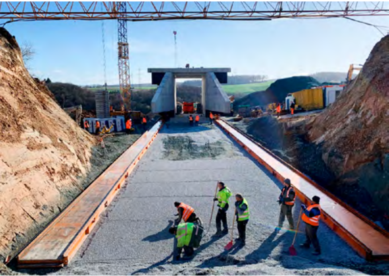
Idstein: Von der Verschub-Bahn „schwebt“ das Bauwerk in die Endlage.
