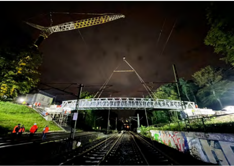
Frankfurt: Der Einhub der Aluminium-Konstruktion erfolgte nachts.
