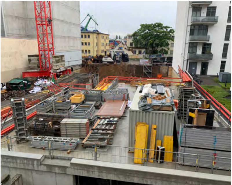
Hinsichtlich der Logistik gibt es für das Baustellenteam einige Herausforderungen zu meistern: Weil Platzmangel herrscht, wird der erste Abschnitt des Parkdecks als Lagerfläche genutzt.
