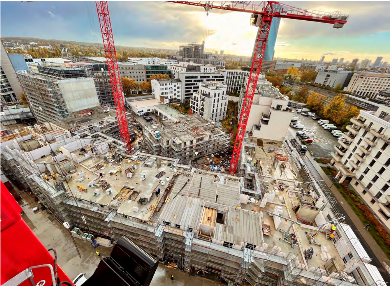
Blick vom Kran 4 auf das Baufeld West: Die Rohbauarbeiten befinden sich aktuell im vierten Obergeschoss und das Gebäude wächst fast im Zwei-Wochen-Takt um ein komplettes Geschoss. Die Lupp-Truppe ist zuversichtlich, den Rohbau für das Baufeld West im Februar 2022 fertigstellen zu können.
