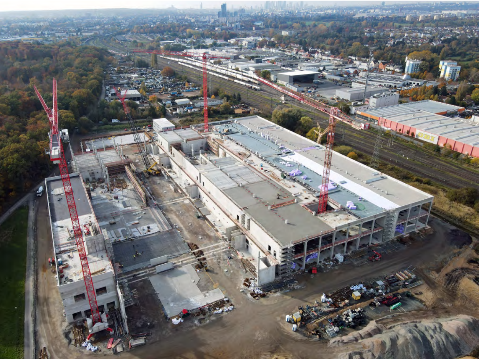
Nur mithilfe einer Drohne ist es möglich, das über 60.000 Quadratmeter große Baufeld eines der größten Rechenzentren Europas auf einem Bild festzuhalten.
