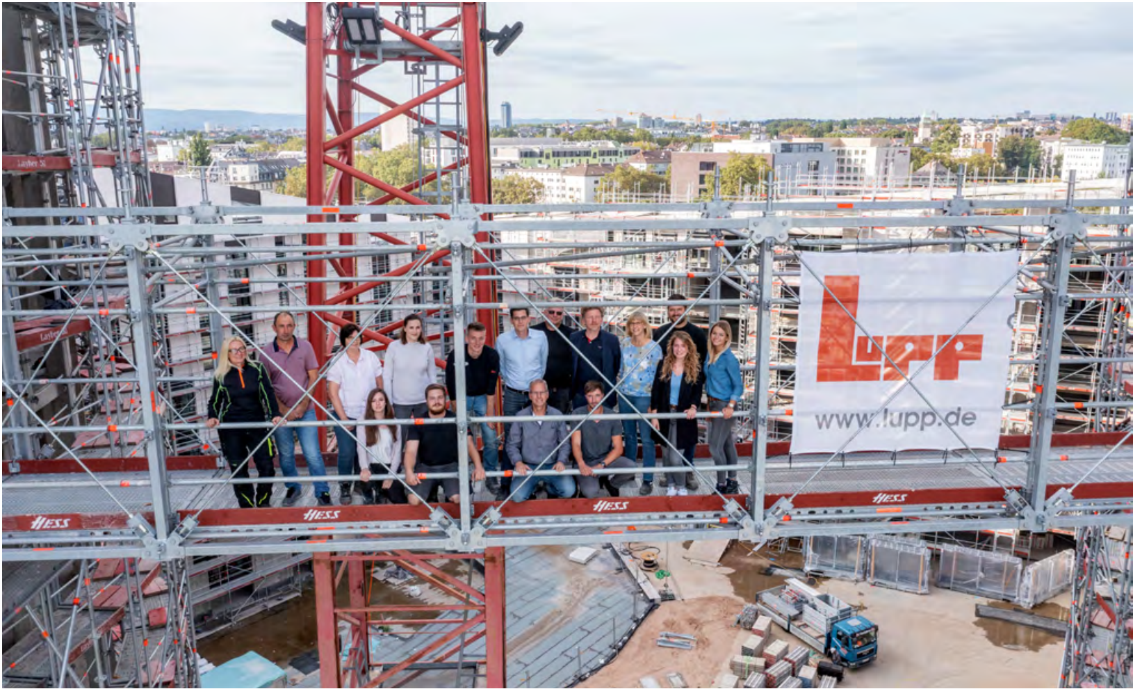
Team: Nach fast zwei Jahren hat sich das Lupp-Team von der Großbaustelle HPQ Living verabschiedet. Aus luftiger Höhe war das beeindruckende Ergebnis besonders gut zu überblicken.
