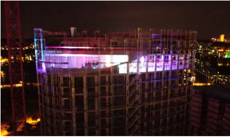
Zum Richtfest wurde die Partyebene im 15. Stock des Wohnturms beleuchtet. Von weitem sah es so aus, als schwebte ein Ufo über dem Hafenpark Quartier.
