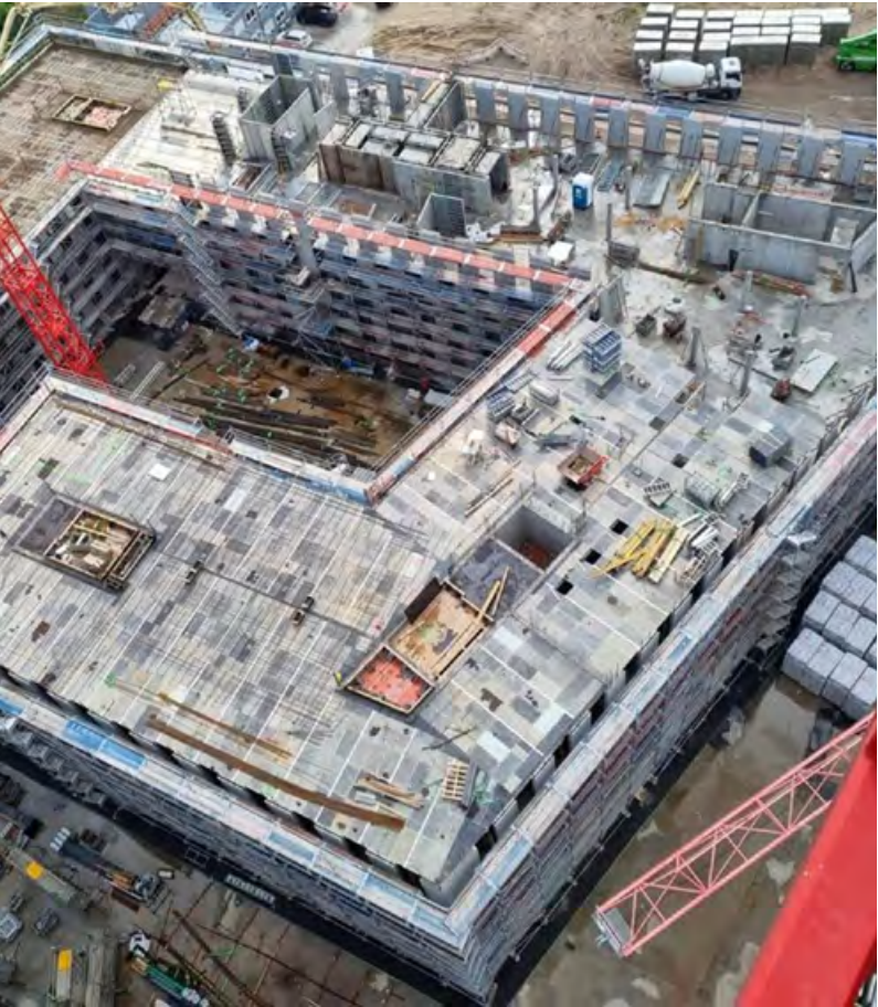
Durch die Optimierung der Arbeitsabläufe konnte der Rohbau auf der Großbaustelle in Berlin-Adlershof deutlich früher als geplant fertiggestellt werden.
