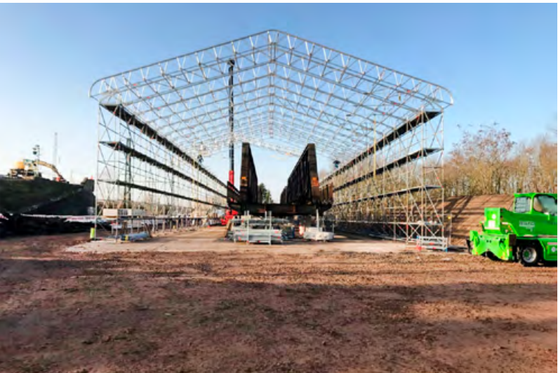
Darmstadt: Für die Sanierung der Brücken wurde ein Zelt errichtet.
