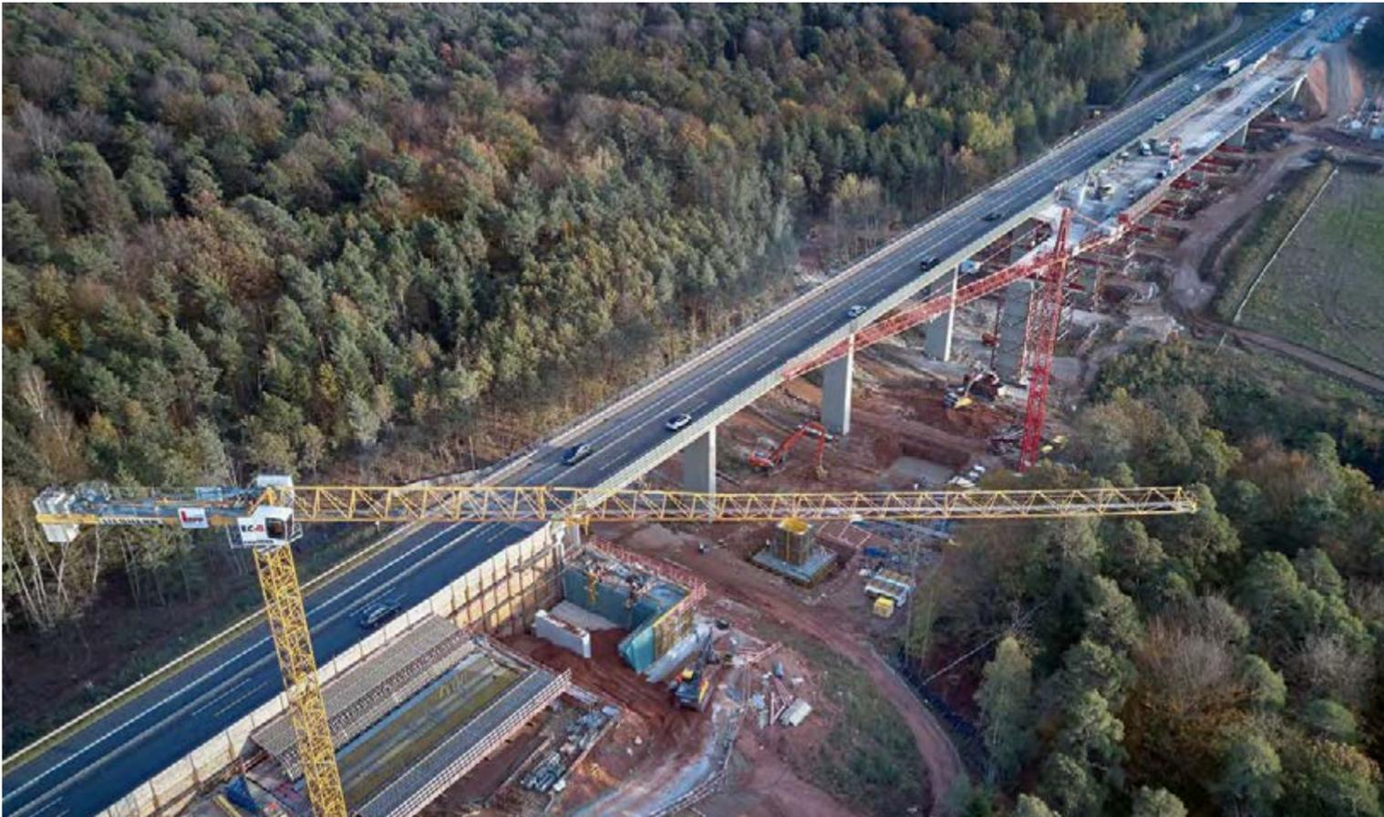
Der neue Überbau wird im sogenannten Taktchiebeverfahren hergestellt. Hierfür wurde eine Taktanlage hinter dem nördlichen Widerlager angeordnet, aus der die fertigen und bis zu 21 Meter langen Überbautakte herausgeschoben werden.
