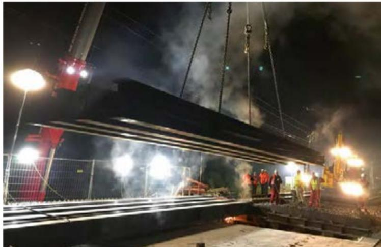
Während der nächtlichen Sperrpause musste die Hilfsbrücke an der EÜ Benzengrundweg zunächst mittels Autokran herausgehoben werden, bevor mit dem Gleisbau begonnen werden konnte.
