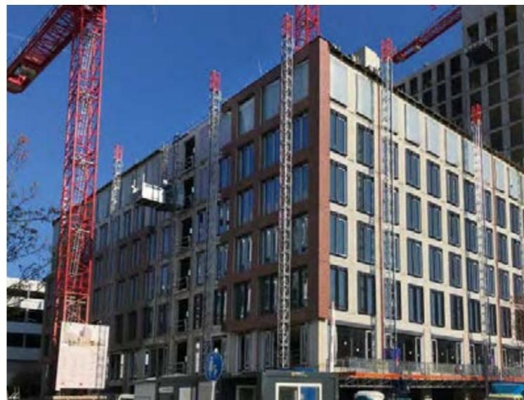
Nach der Fenstermontage im Blockrandbereich werden die vorgehängten Klinker-Fertigteilelemente am Rohbau befestigt.
