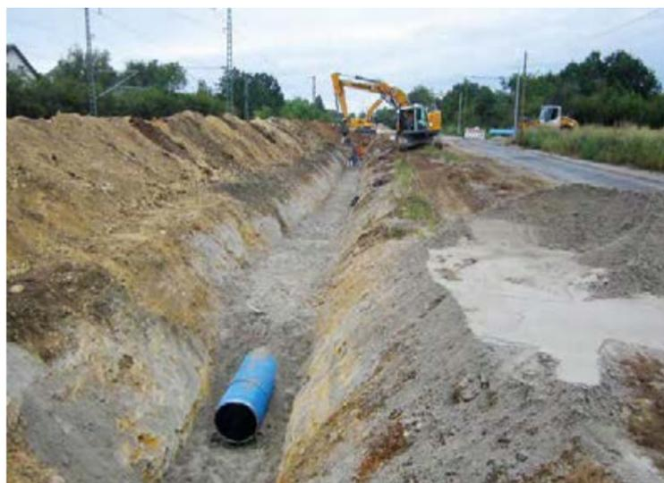
Da im Baufeld ausreichend Platz vorhanden war, konnte der Rohrgraben geböschet ausgeführt werden. Nachdem die duktilen Muffendruckrohre in der vorbereiteten Sandsohle verlegt sowie mit dem BLS-Steckmuffensystem formschlüssig gesichert waren, wurden sie eingesandet und wieder verfüllt.
